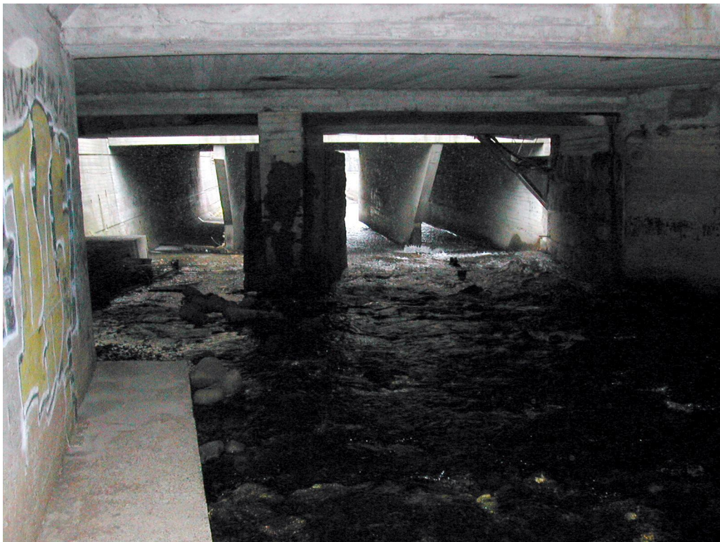
Fig. 6 Bilde fra kulverten litt nedenfor utslippsstedet. Bunnen er tilsvarende lenger opp i kulverten. Det er god fart på vannet og steiner på bunnen som forsterker blandingen.
