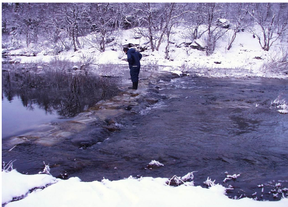
Bilde 1 : Situasjonen i elva ut av Storvann nord den 6. november 2001, ca midt på dagen. Vannføring er stipulert til ca 0.2 m 3 /s. Terskel av sandsekker ses tydelig. Foto; Harstad kommune.
