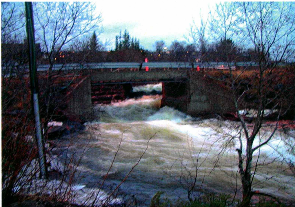
Bilde 2 : Flom i Futelva 7. januar 2002 ca kl 12 - 1300. Strømningen gjennom bruene. Sett motstrøms fra nederste bru. Vannføring ca 11 – 12 m 3 /s.
