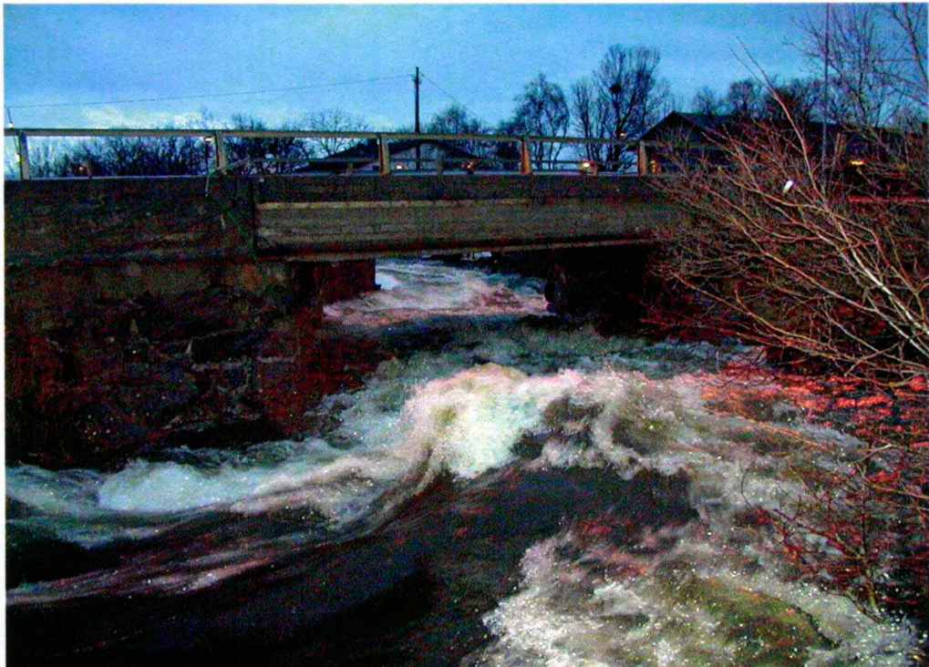
Bilde 1 : Flom i Futelva 7. januar 2002 ca kl 12 - 1300. Strømningen gjennom bruene. Sett medstrøms før riksvegbrua. Vannføring ca 11 – 12 m 3 /s.
