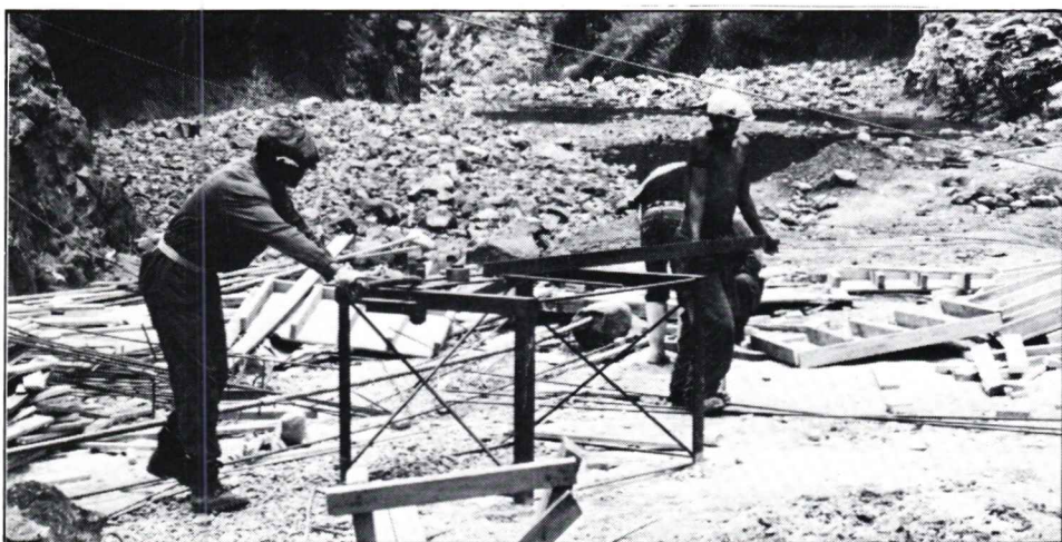
Lokale jernbindere i arbeid.
