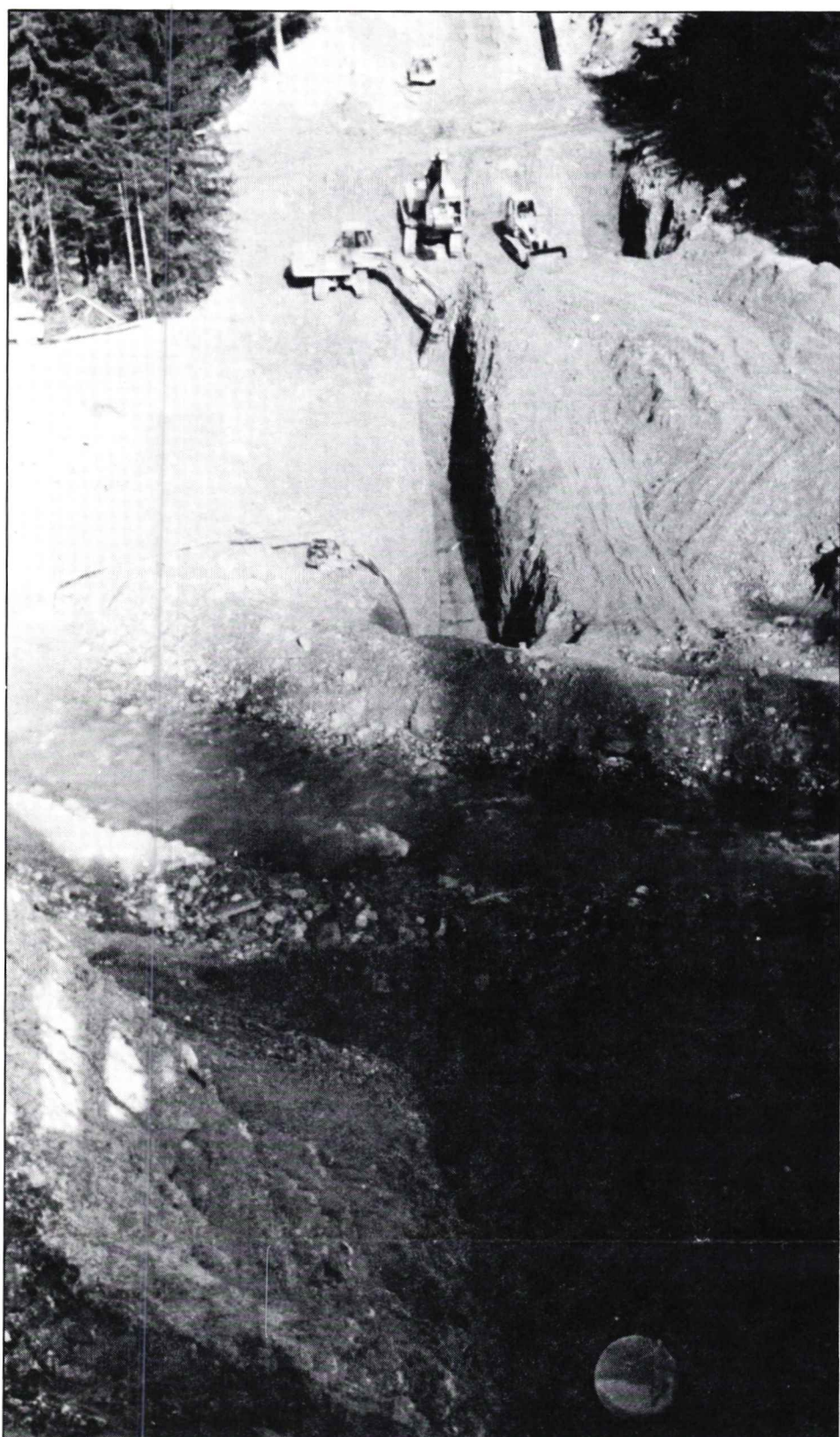
Under kryssningsarbeidet ble elveløpet midlertidig flyttet frem og tilbake.
