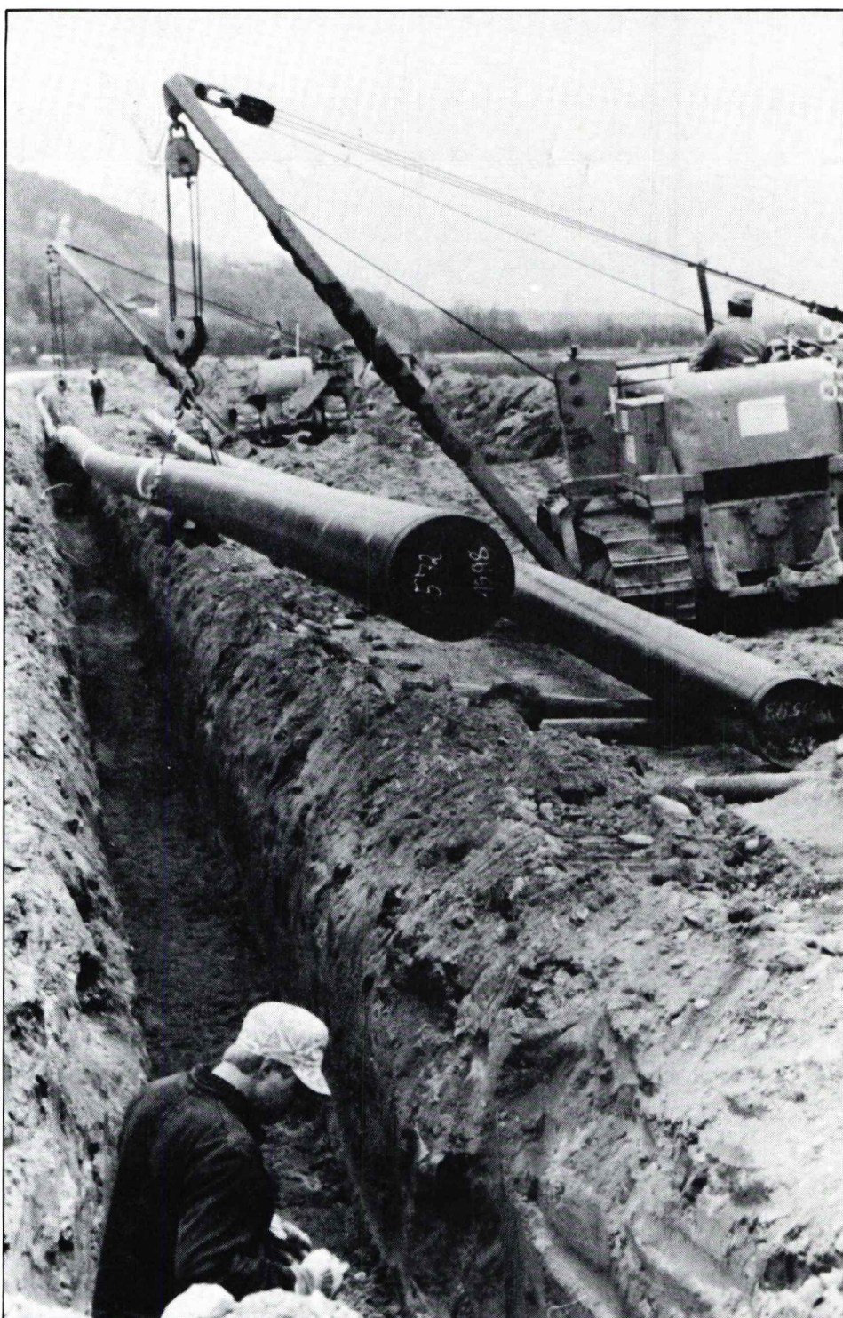
Anleggsarbeidet med middelstore gassrør kan under ideelle forhold ha en fremdrift på 2000 meter i døgnet.
