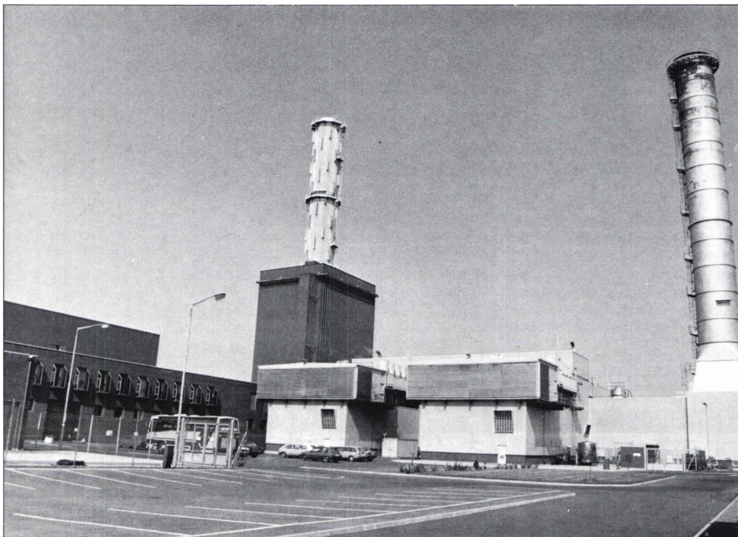
Gasskraftverket North Wall i Dublin.
