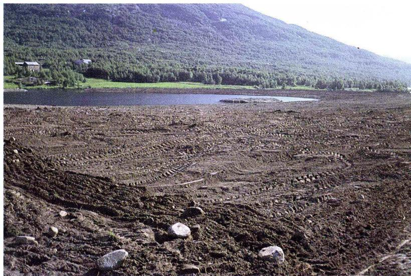
Fig. 29 Finplanering av massetaket (harving) ved Fet. (09.07.81).
