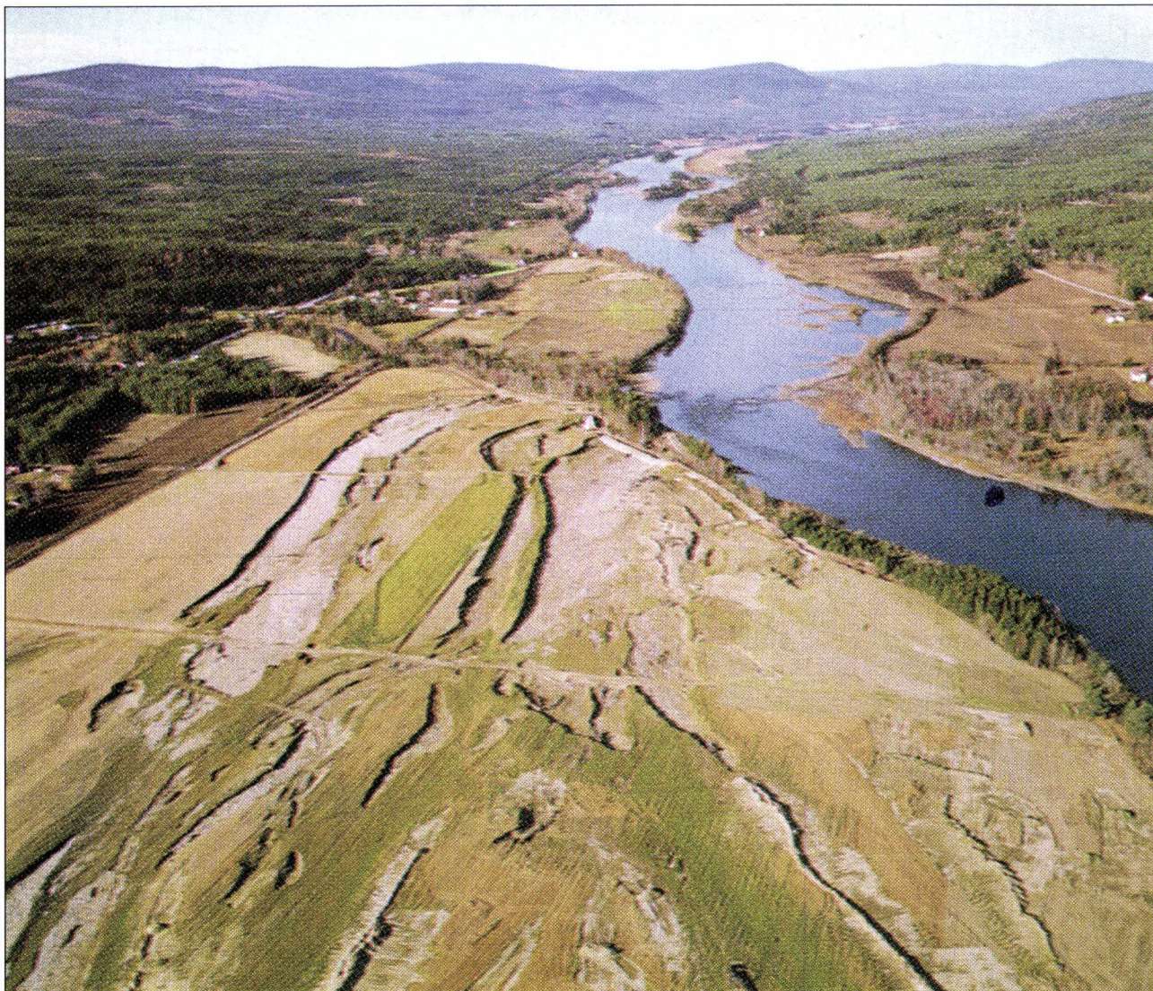
Figur 10. Flomskade på Øksna i Elverum. Brudd i flomverk med påfølgende vannstrøm over arealet under hele oversvømmelsen.
