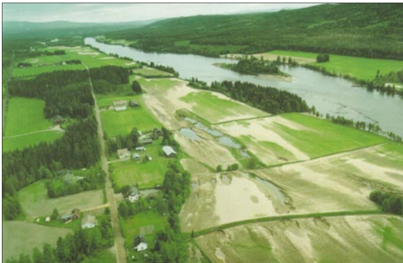
Figur 1.7 Flomskade på Rustad-området i Elverum. Graveskader framkalt av turbulens i eiendomsdeler. (Foto: FOTONOR AS)
