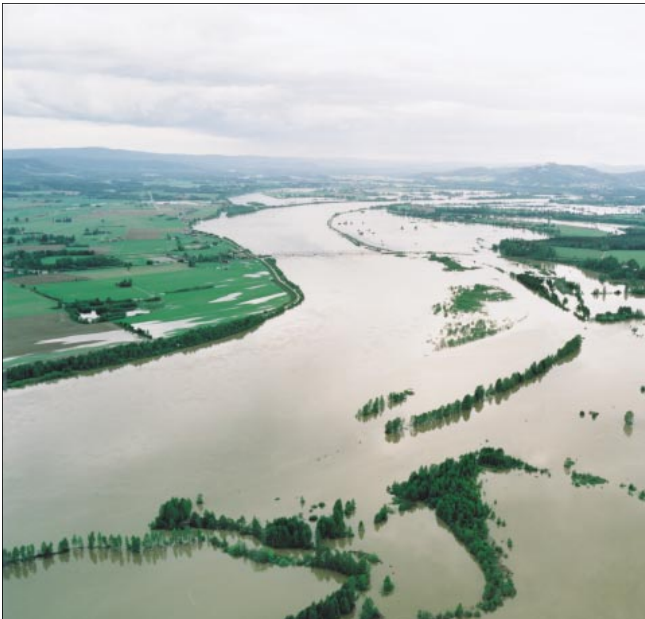
Figur 1.18 Glomma ved Arneberg bru i Åsnes kommune, fotografert 3. juni 1995. Flomverk på begge sider av elva – flomverket til venstre hindrer oversvømmelse av elvesletta, mens brudd har oppstått i flomverket til høyre. (Foto: Hallvard Berg)
