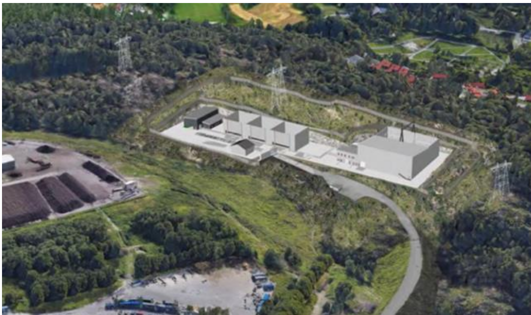
Flymontasje/3D-modell av innendørs transformatorstasjon.
