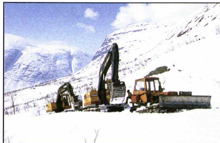
Tunge maskiner skal frem til Viva ved Styggvatnet. Derfor ble det allerede i april ryddet snøveg på denne strekningen. Få dager senere startet snøsmeltingen.
