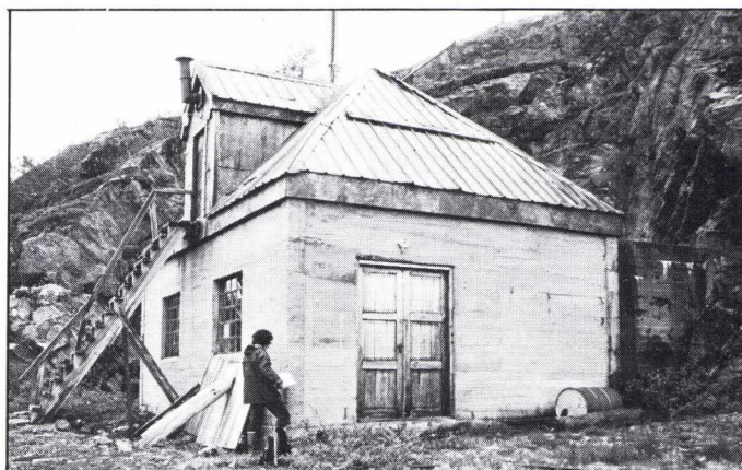
Lukehus ved Storglomvatn bygget i årene 1912–1914.
