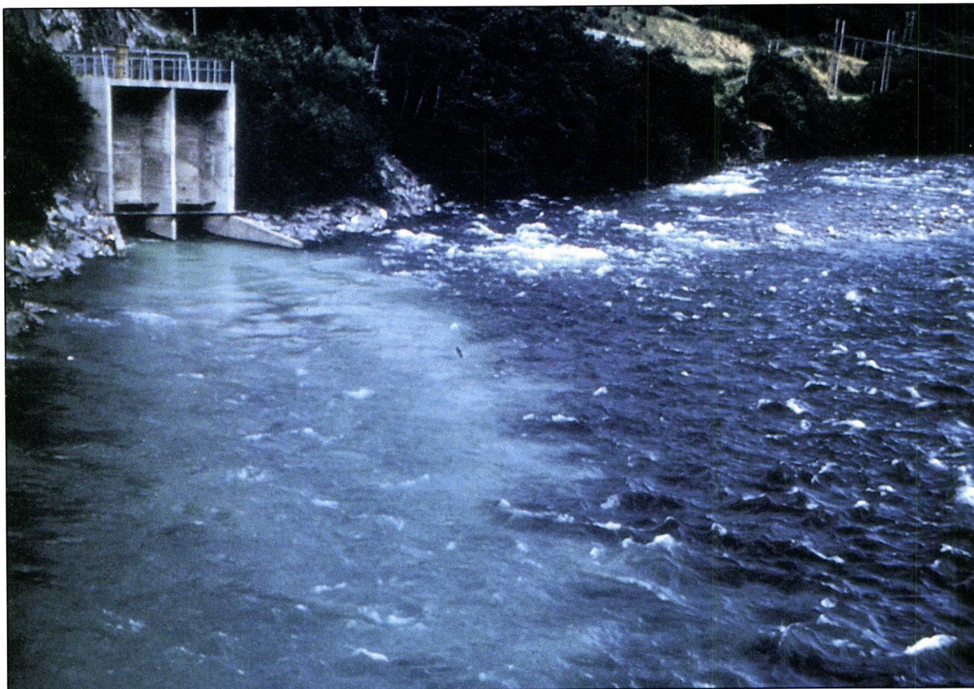
Utløpet ved Driva kraftverk. Foto: Morten Lund
