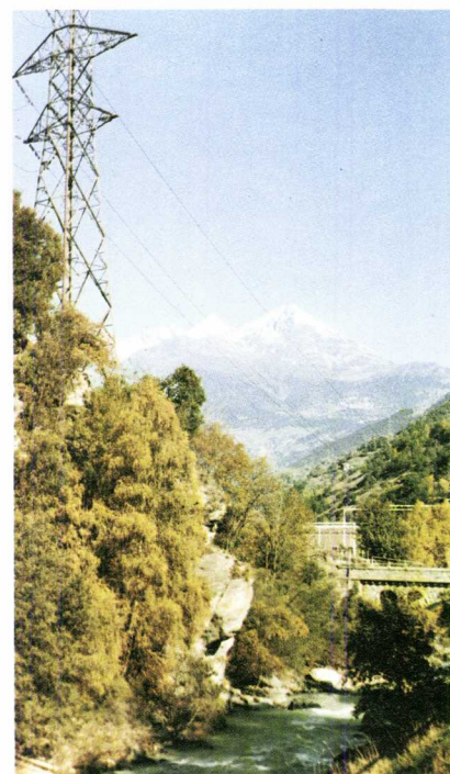
Naturinntrykk fra Stalden, koblingsanlegget sees i bakgrunnen.
