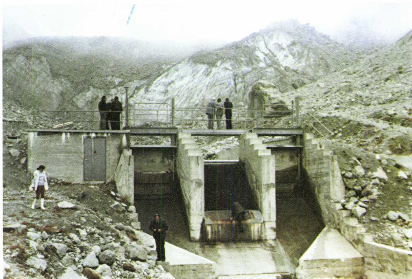
Bekkeinntak ved Grande Dixence på hver side av inntaksristen er det montert tappeluke for utspyling av det ovenforliggende sandfang.
