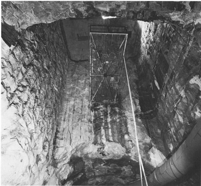
Dette er lukesjakten 95 m 3 ved Oddatjørn-inntaket til Saurdal kraftverk ved Ulla-Førre-anlegget. Veteranene P. Sperstad og J. Fredriksen sto for boringen, og viste at fjell også kan formes.
