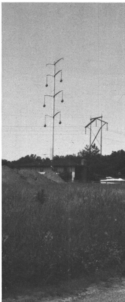
Moderne mastekonstruksjon for 345 kV brukt av Northern States Power Company, (ved siden av gammel kraftledning).
