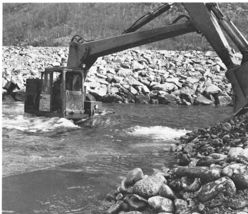
Vassføring på 15 m 3 /s under bygging av tersklene viste seg å være i meste laget, spesielt hvor det eksisterte en markert djupål.
