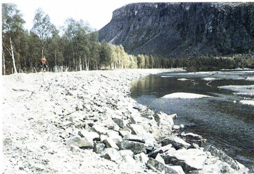
Glimt fra noe av det forbyggingsarbeid fagsjef Bård Andersen og hans mannskaper har hatt ansvaret for i Alta.
