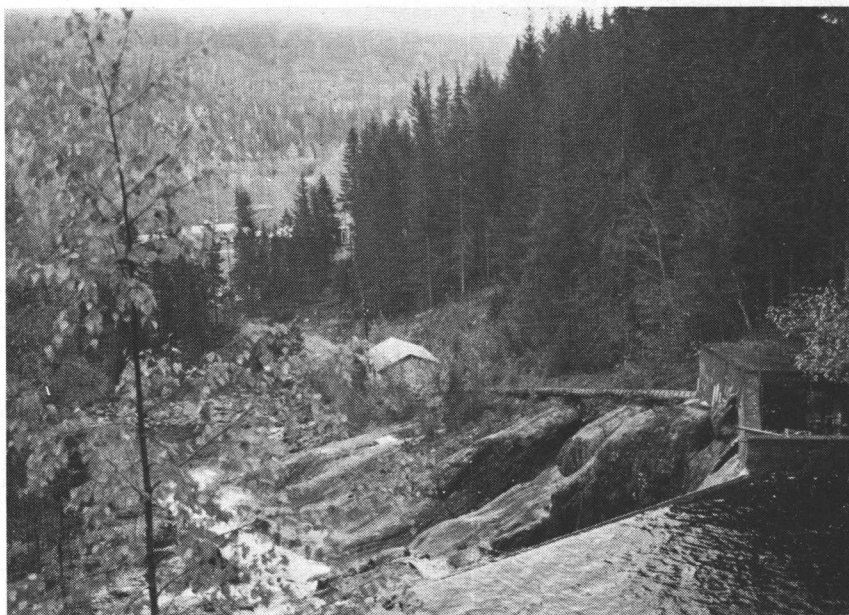
Gammelt bydekraftverk fra Nore i Numedal.
