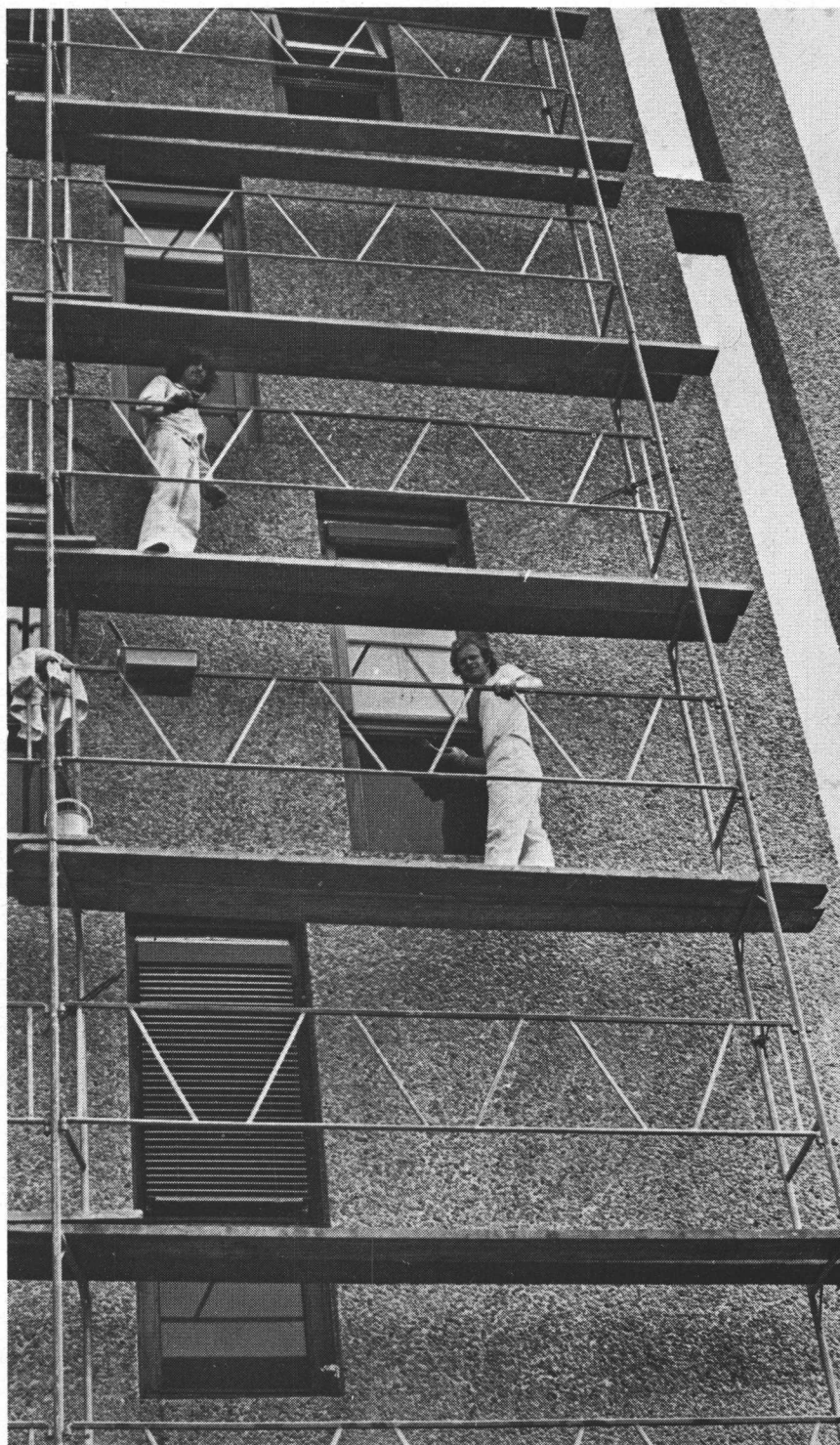
Teakinnfatningen rundt 1400 vinduer i Middelthuns gt. 29 har NVE å holde vedlike, og det skjer ikke på noen tilfeldig måte. Nærmest vitenskapelig har man gått fram for å oppnå best mulig resultat. Det er et par av folkene til malermesterfirmaet Nils Onstad som her «smører» det vedlikeholdende produkt.
