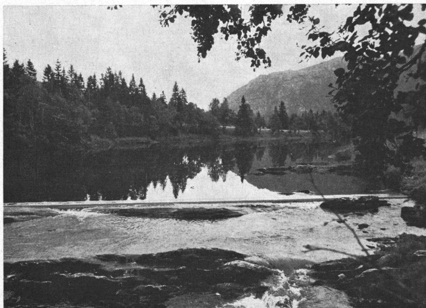
En enkel betongterskel - god virkning.
