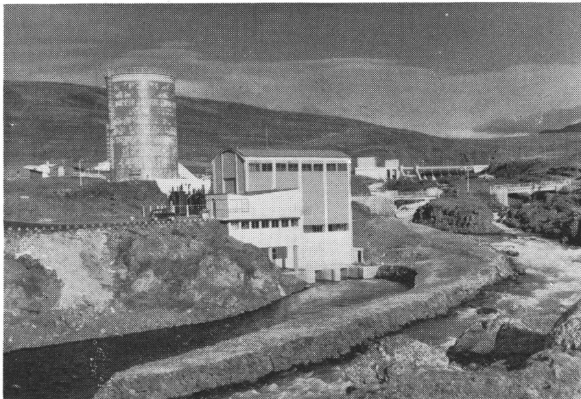
Laxá kraftanlæg i Nord-Island, der forsyner Islands næststørste by, Akureyri, samt nærliggende byer og landområder med elektrisk kraft.
