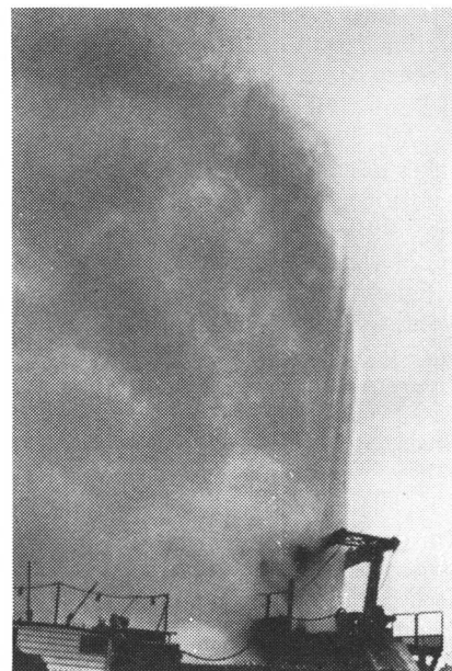
Resultatet af en boring midt i Reykjavík nu i vinter. En blanding af varmt vann og damp strømmer fra et 740 m dybt borehul. Temperaturen ved hullets bund er omkring 130° C.
