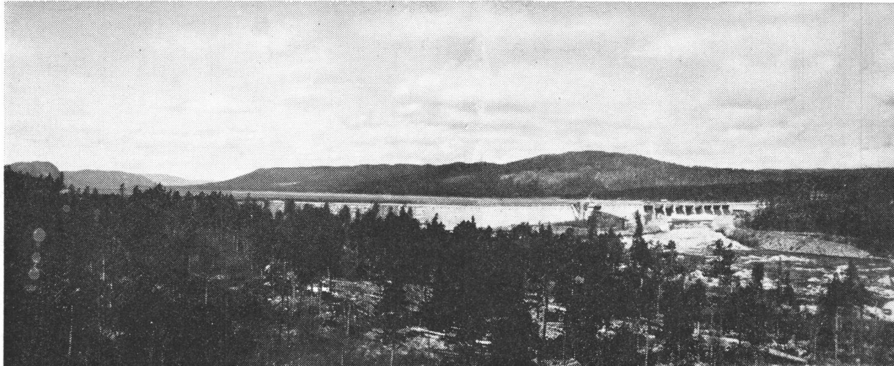
Pålsludammen under bygging.
