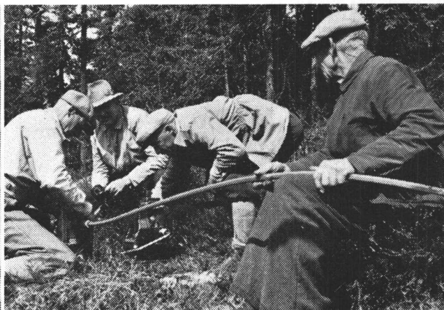
Linereparasjon ved Rognset i Eggedal.
