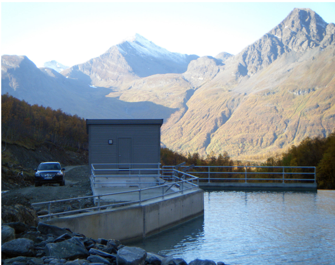
Inntak Ellenelva, Tromsø. Foto: Kjetil Greiner Solberg.
