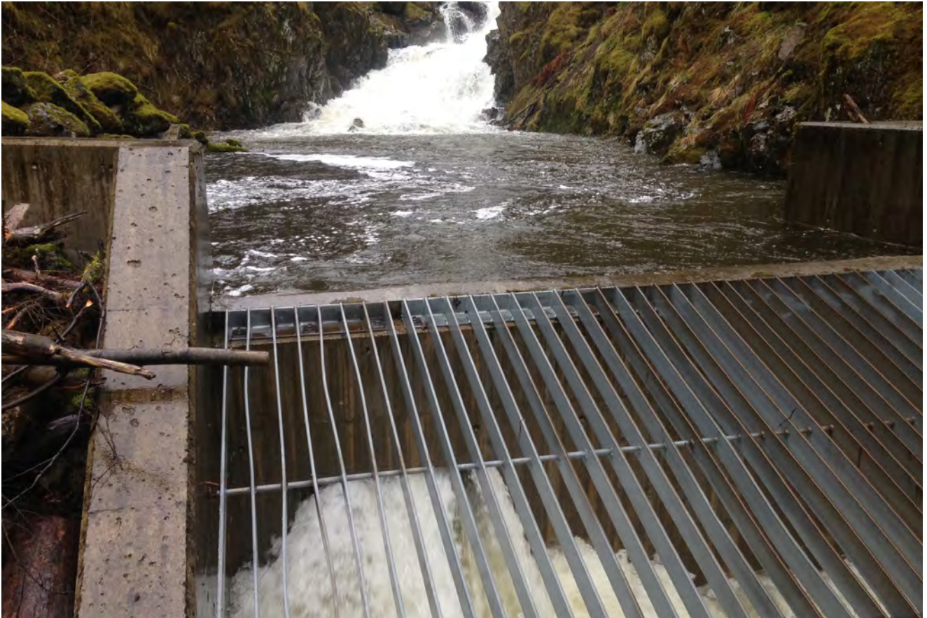
Is og trevirke skyves over rista som holdes åpen under flom. Foto: Ove Madsen.
