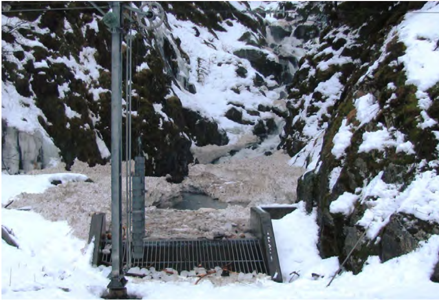
Bekkeinntak ved Langhelle med flomvannføring/isgang. Foto Ove Madsen.
