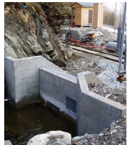
Bekkeinntak ved Langhelle ved middels /lav vannføring. Foto Jeanette Gundersen
