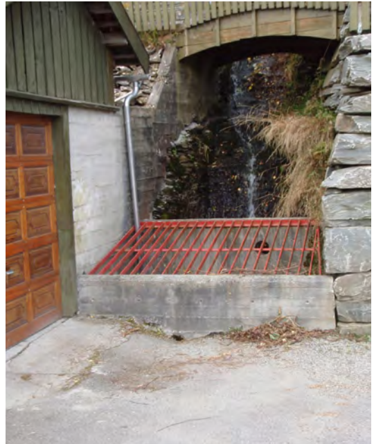
Bekkeinntak med selvrensensende rister, ved minstevannføring, foto Ole Erik Almenningen
