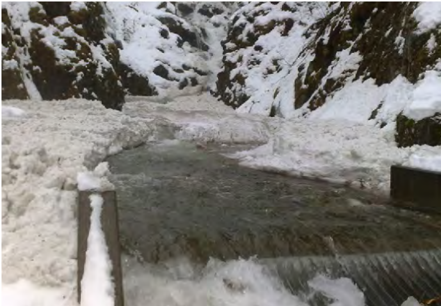
Bekkeinntak ved Langhelle med flomvannføring/isgang. Foto Ove Madsen.
