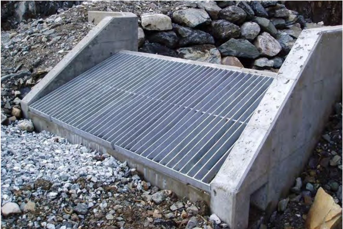
Bekkeinntak ved Langhelle ved middels /lav vannføring. Foto Jeanette Gundersen
