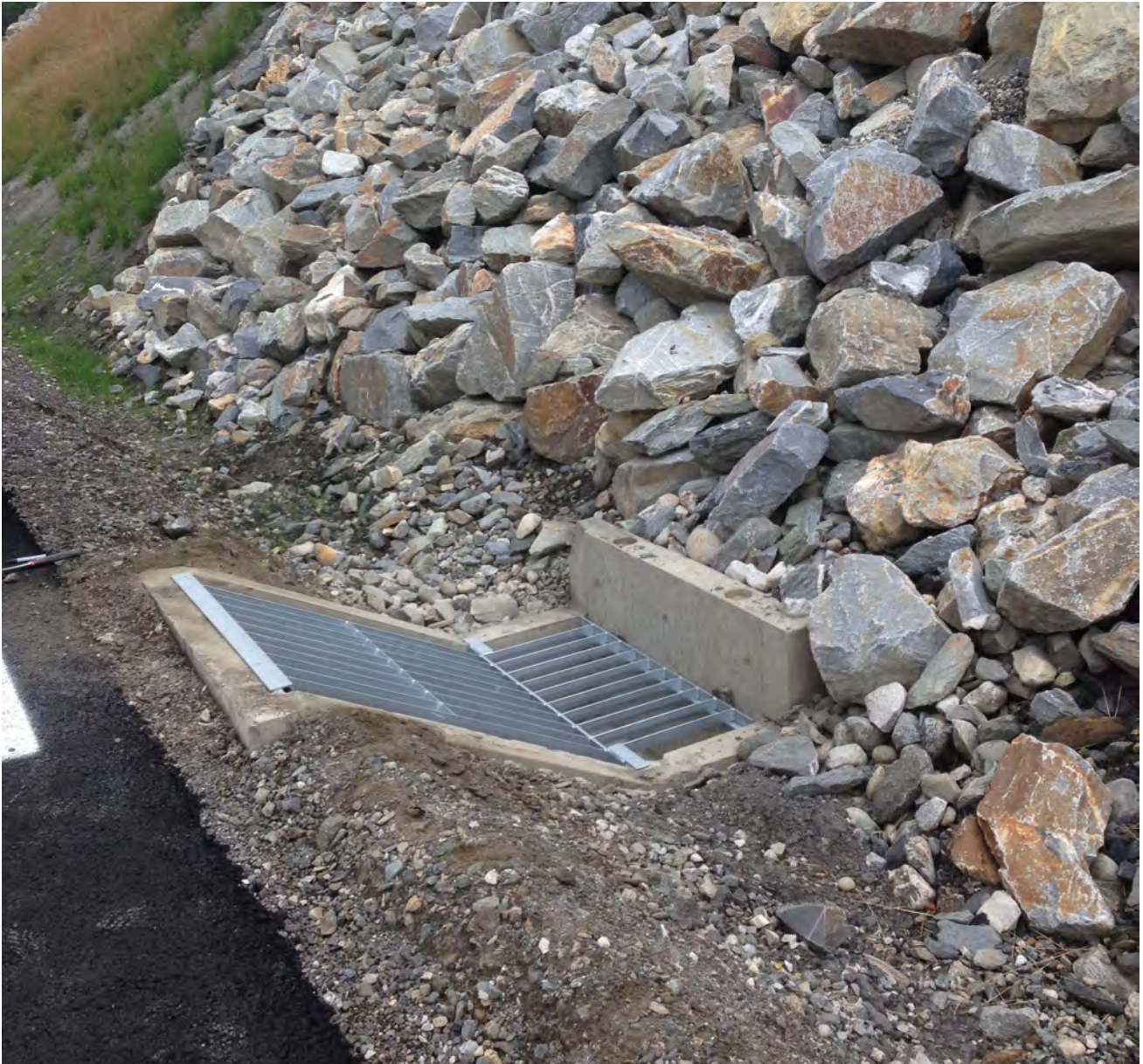
Inntak nedsatt i grøft (Foto: Per Arne Kolseth).
