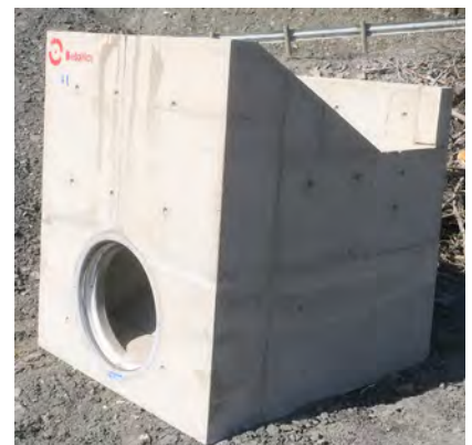
Ferdig støpt inntak før nedsetting i grøft (foto: Per Arne K).
