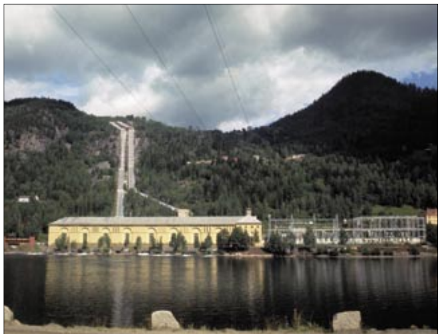
Nore I ble bygget fra 1919-28 og er tegnet av arkitektene Lorentz H. Ree og Carl Buch. Anlegget ble gradvis utvidet fra 4 til 8 aggregater, med det siste i 1955. I dag er rørgaten erstattet av ny vannvei i fjell, og rørene er bevart som kulturminne. Foto: NVE
