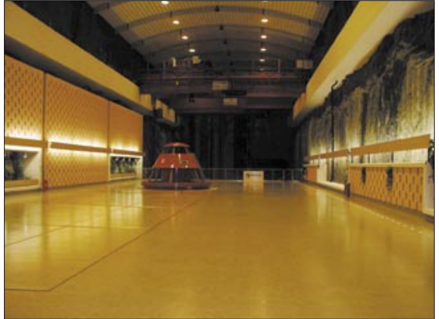
Svartisen kraftverk ble satt i drift i 1993. Anlegget ligger i fjell og har Norges største aggregat på 350 MW. Kraftverket utnytter et nedbørsfelt på ca. 560 km 2 . Anlegget har ca. 100 km med tunneler og omtrent 50 bekkeinntak. Foto: Statkraft SF
