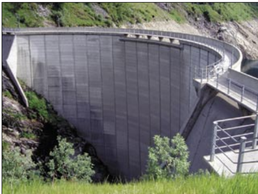
Dam Zackariasvatn i Tafjord ble i 1976 tildelt Betongplaten for materialbruk og god arkitektur. Dammen er en hvelvdam med høyde på 90 meter. Foto: NVE
