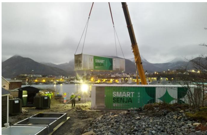
Bilde 3. Ett av batteriene i piloten Smart Senja løftes på plass. Foto: Smart Senja / Johannes Fjell Hojem
