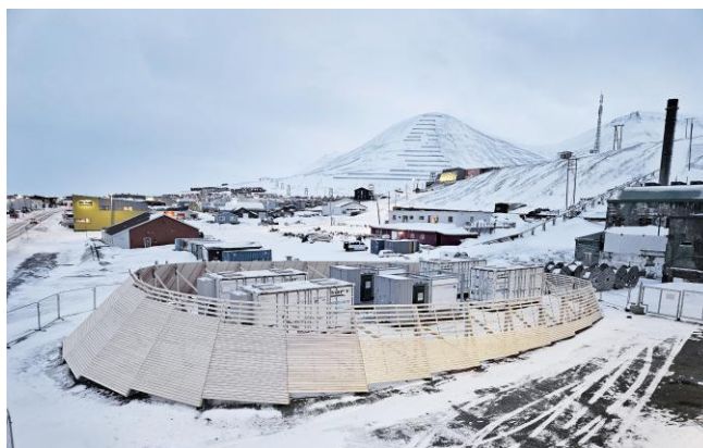
Bilde 2. Et 8,8 MW/9,2 MWh batterianlegg bidrar til å bedre kraftforsyningen i Longyearbyen. Foto: Svalbard Energi
