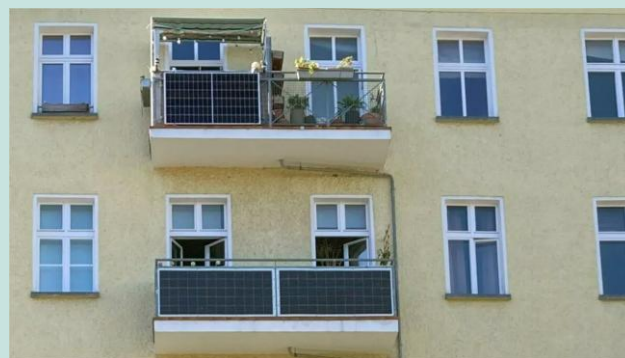
Bilde 1. Balkongkraftverk i Berlin. I Tyskland har det blitt stadig vanligere at forbrukere installerer kombinerte solcelle- og batterianlegg for å øke egenforbruket av solkraft. Foto: Olav A. Øvrebø / Energi og klima
