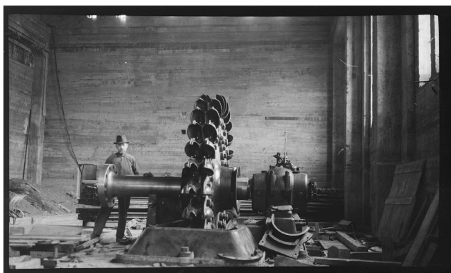
Figur 4: Montasje av et av de første Peltonløpehjulene i Hakavik kraftverk.
