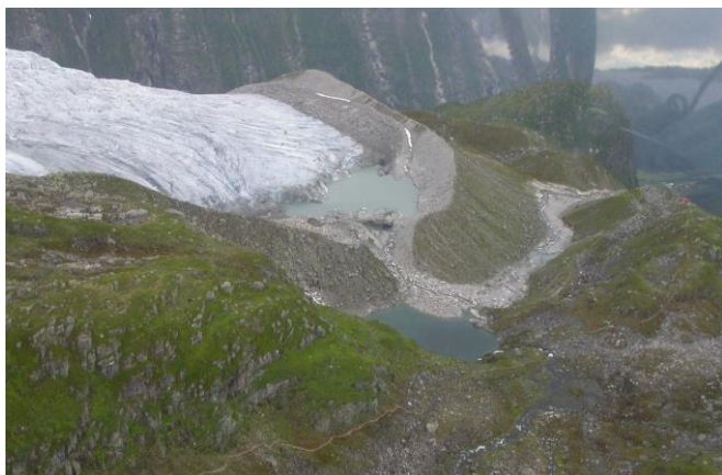
Drenering av morenedemt sjø ved Flatbreen, Jostedalsbreen, august 2004. Moreneryggen brast og vannet ble delvis tømt gjennom ryggen og forårsaket flomskred og stor skade i Supphelledalen. Foto: Hallgeir Elvehøy.
