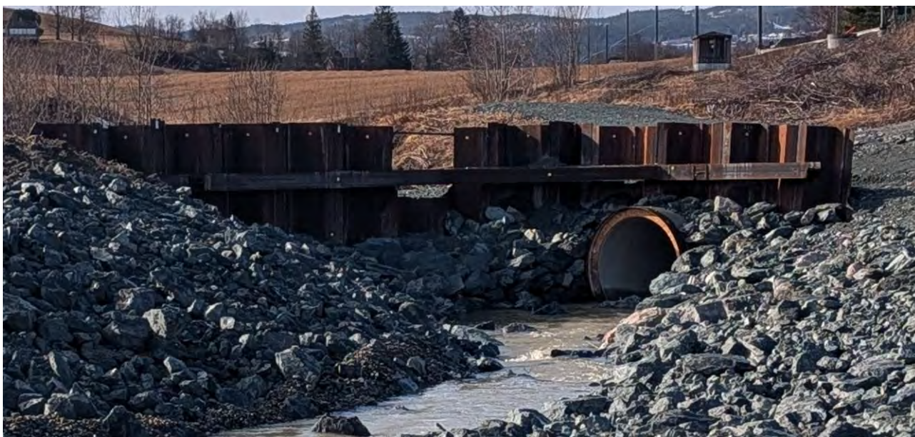
Figur 9 Voll med spuntvegg som stenger det tidligere elveløpet i Langbekken, med konstruksjon rundt innløpet til kulvert 1. Foto fra befaringen, se befaringsnotatet.
