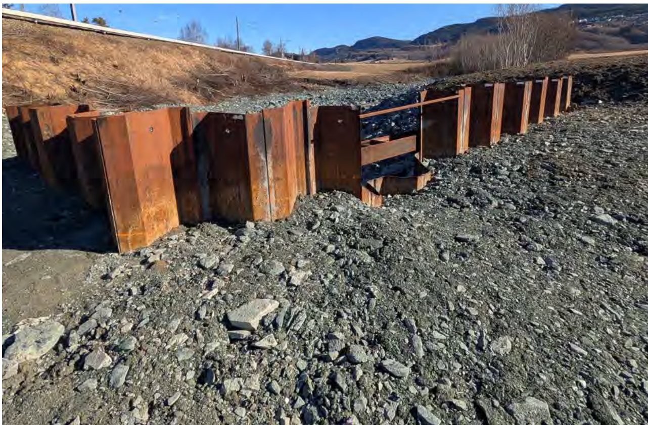
Figur 10 Voll med spuntvegg som stenger det tidligere elveløpet i Langbekken, med konstruksjon rundt innløpet til kulvert 1. Foto fra befaringen, se befaringsnotatet. Sett bakfra.
