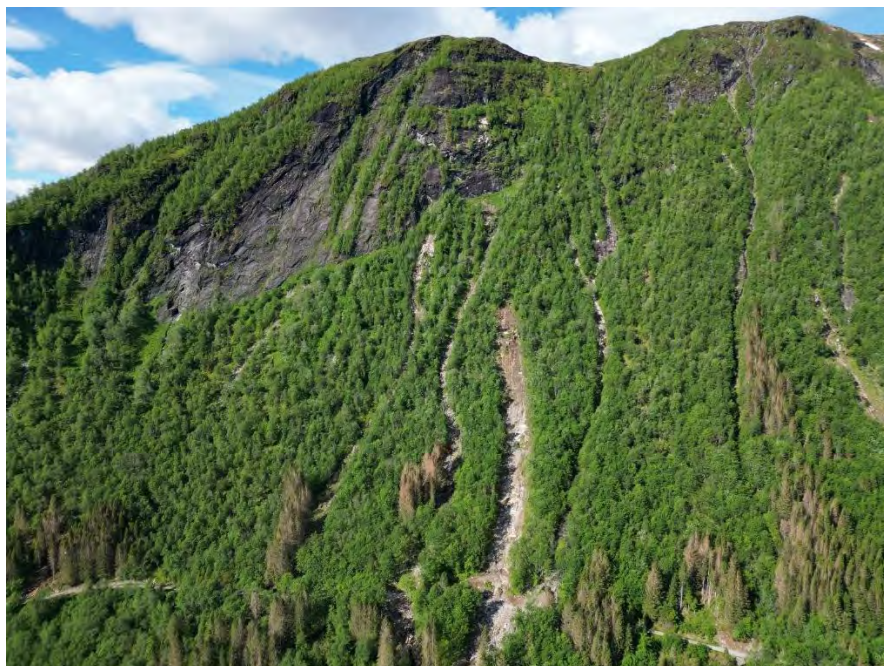
Foto 30 Skredbane 3, 5 (de 3 midtre løpene) og 6,
