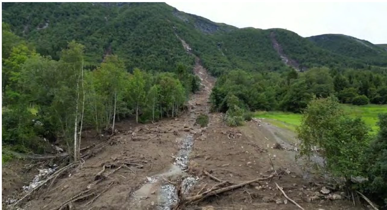
Foto 17 Skred nr 2 (Nygård, 2023)
