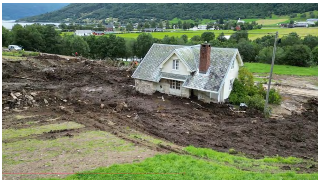
Foto 16 Massen har ligget høyt opp på veggen. (Nygård, 2023)
