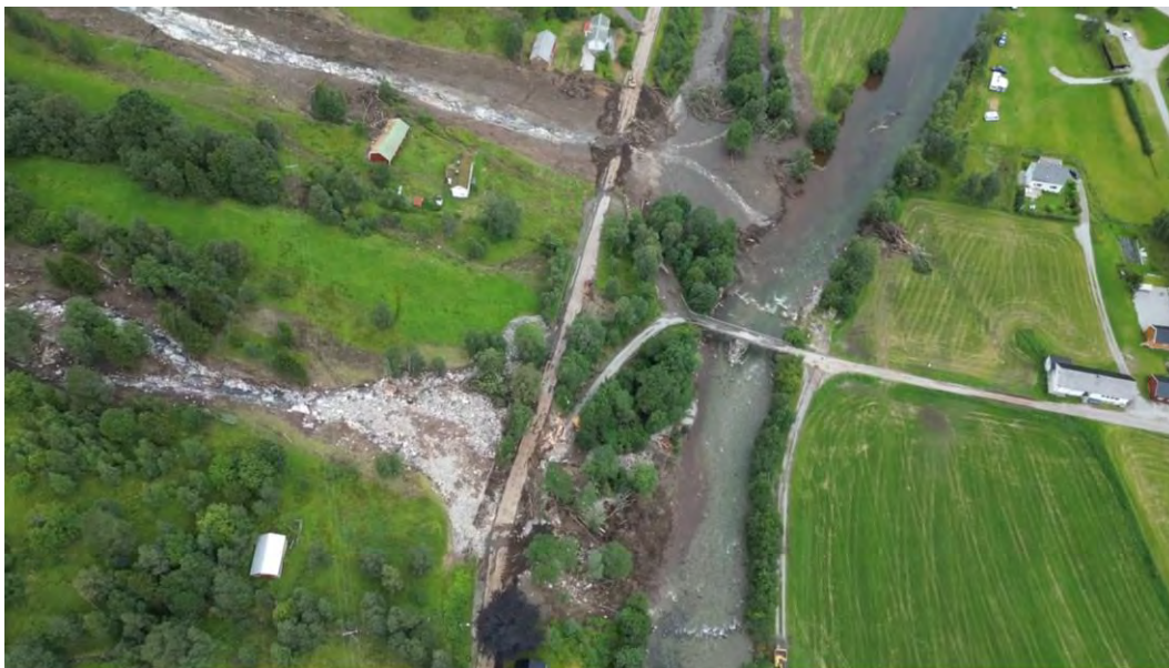
Foto 13 Nedre del av skredløp 1, to utløp. Skredet har presset seg over til motsatt bredd.
