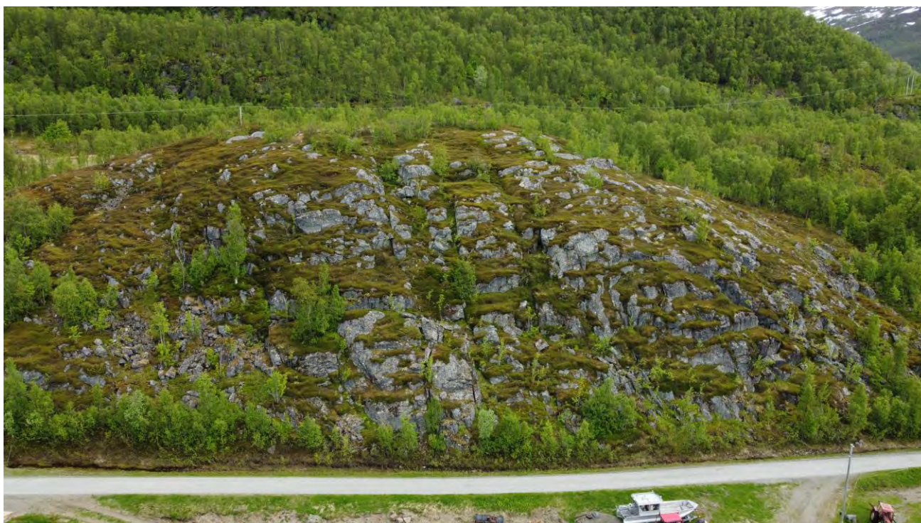
Foto 3.14. Varberget nord i området er generelt rundet og glatt, men vertikale sprekkesoner gir avløste blokker < 1 m 3 flere steder. Nedfall mot veien er sannsynligvis ryddet vekk, i venstre del er det synlige avsetninger.
