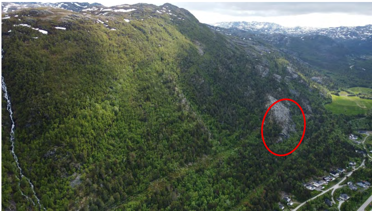
Foto 8.3. Dronefoto over sørlig del av påvirkningsområdet. Langberget er den vegetasjonsfrie bergskrenten i kanten av kartleggingsområdet markert i rødt.
