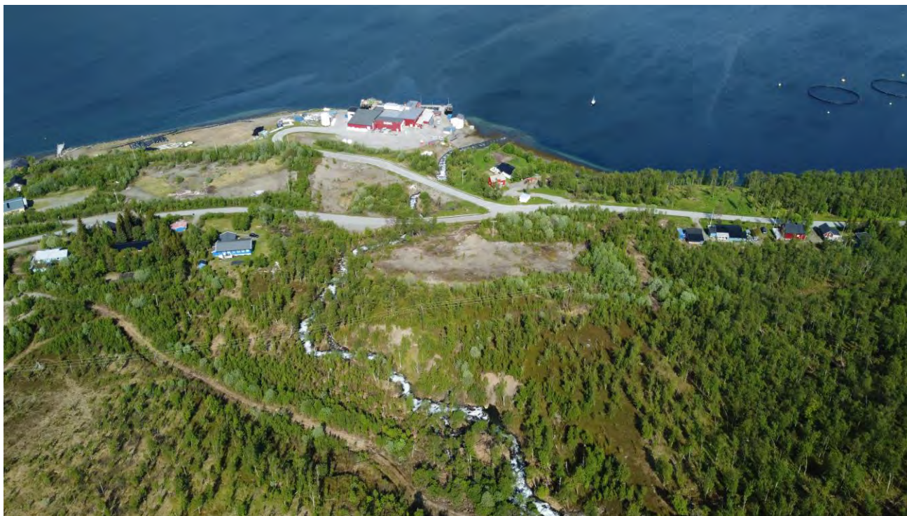
Foto 5.5. Foto av utløp av Glopeelva ved Gulpenjarga, sett mot nord. I elveskrenten er det spor etter kollaps av løsmasser (jordskred) som har gått i elva.
