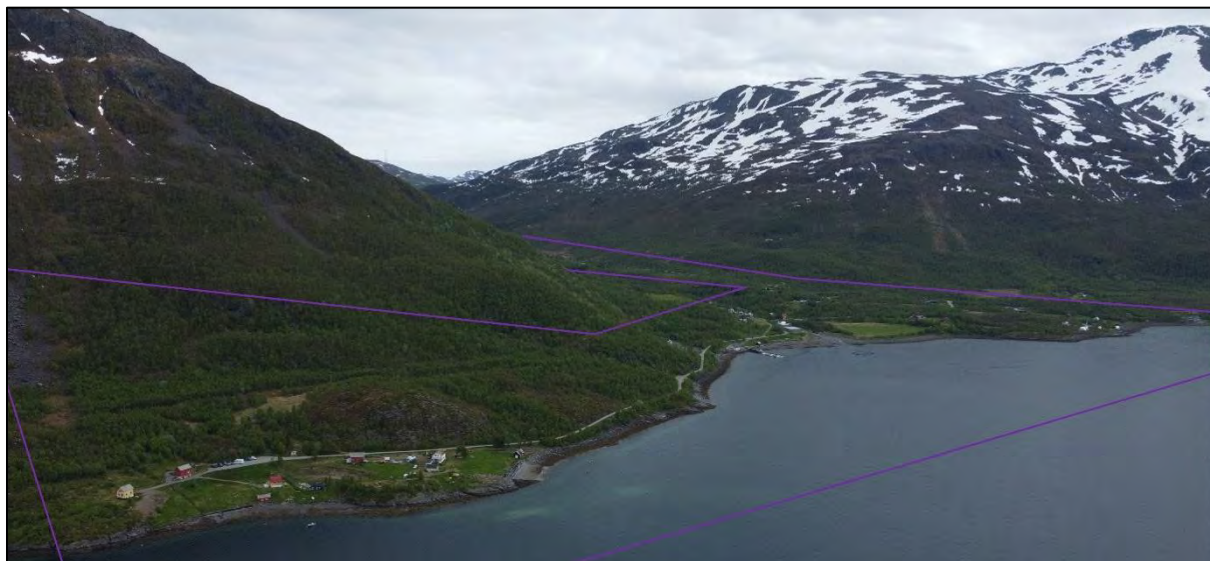
Figur 22. Jøkelfjordeidet sett mot sørøst. Solheim helt til venstre, Store Kobbelva/Vikselva sentralt i bildet og Aslakneset under Olderbakkfjellet til høyre.
