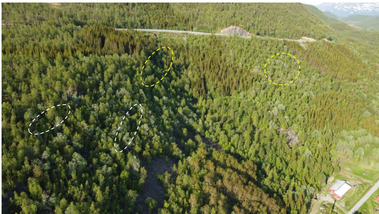
Foto 2.14. Bergskrenter med løsneområder for steinsprang (så vidt synlige inni skogen til venstre markert med hvitstiplede ellipser) ovenfor Bukta. Løsneområder for snøskred uten skog mellom granskogfeltene litt over senter av bildet og i underkant av stor vegskjæring i høyre del av bildet (markert med gulstiplede sirkler).
