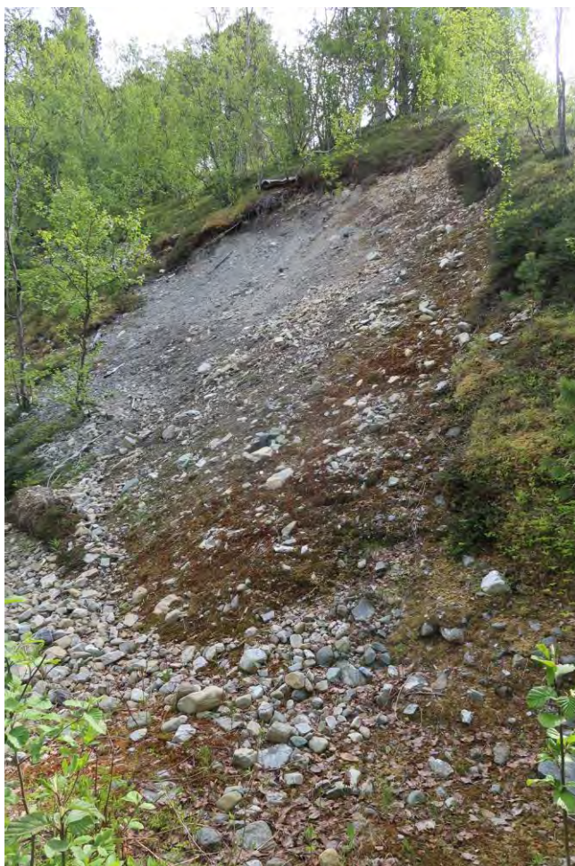
Foto 8.8. Løsmasseskråning ned i ravinene.
