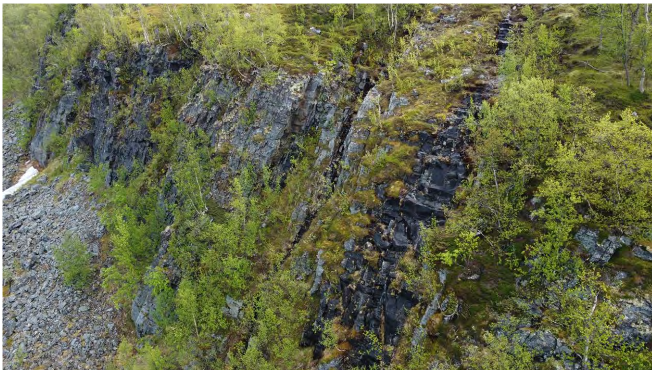
Foto 5.7. Bergklipper som utgjør løснеområder for steinsprang på østsiden av Golpeelva ca. 150-200 moh. I ura under er det spor etter ferske utfall < 1 \text{ m}^3 , og sjeldnere utfall < 3 \text{ m}^3 .
