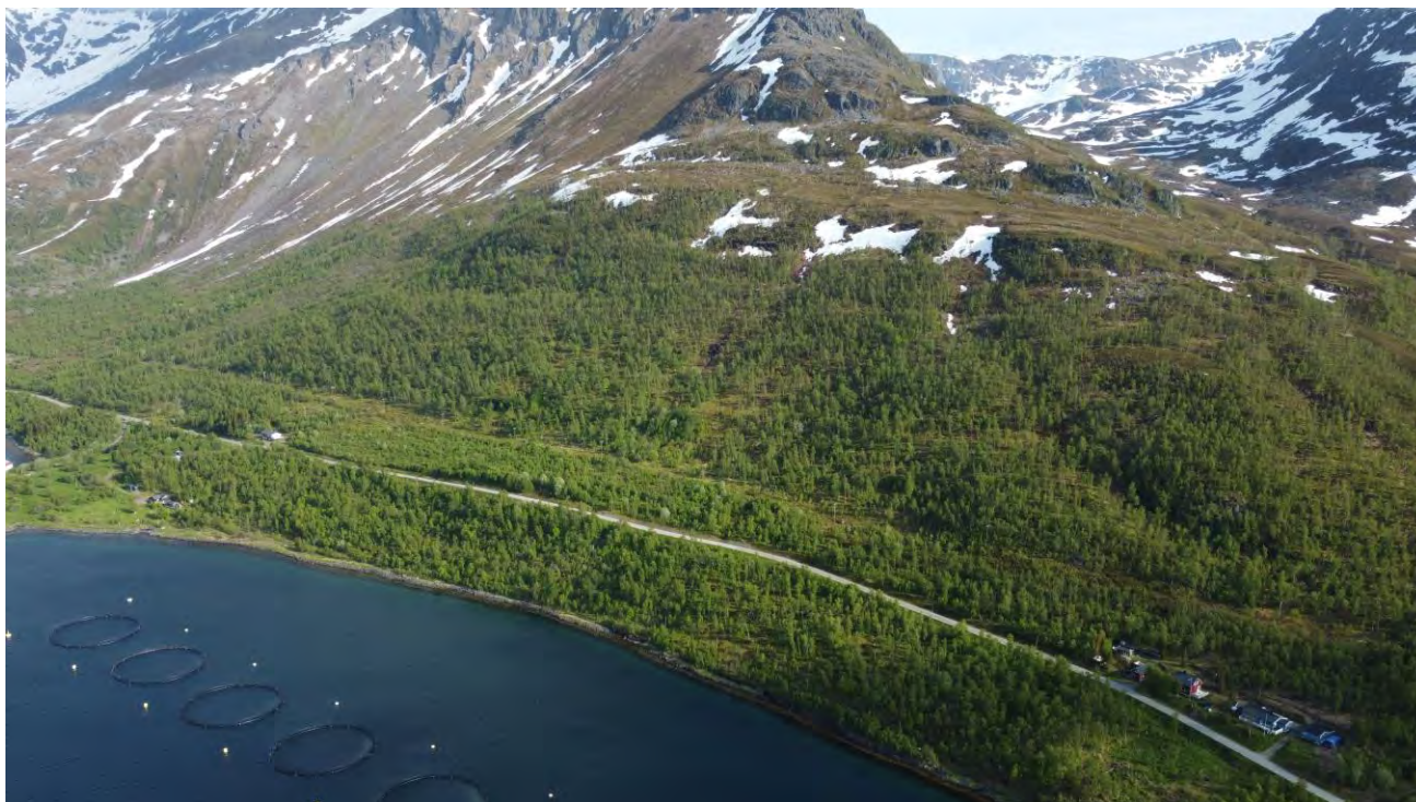
Foto 5.3. Foto av østlige deler av påvirkningsområdet, sett mot sørøst. Oppdrettsanlegget 140 m fra land ble ødelagt av snøskred i 2002. Løsneområder for snøskred ved snøfeltene sentralt i bildet. Løsneområder for steinsprang med underliggende ur er synlig bak det flattere partiet, ca. 200-350 moh.
