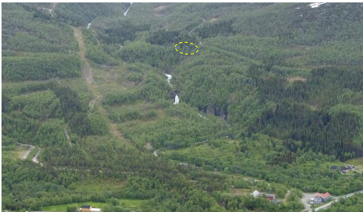
Foto 2.20. Løснеområde for snøskred litt over midten av senter av bildet markert med gulstiplet ellipse.
