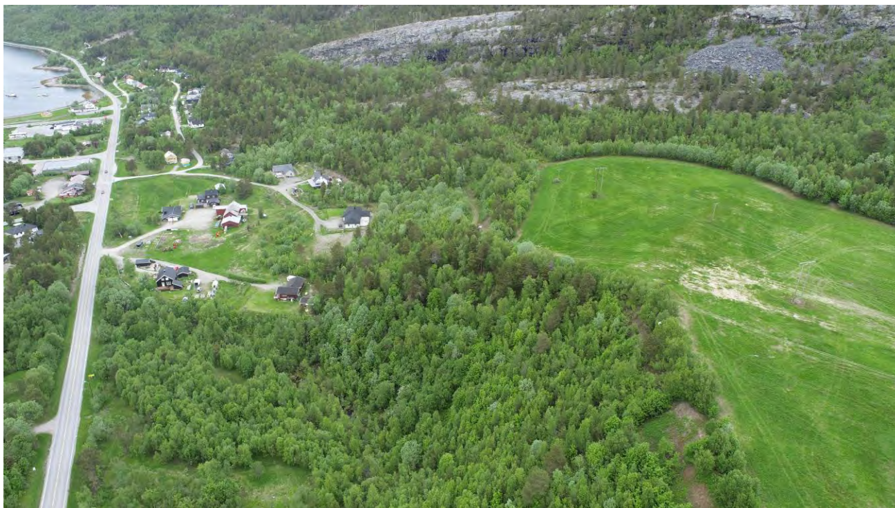
Foto 8.19. Dronefoto av bratt løsmasseskråning sør i kartleggingsområdet.
