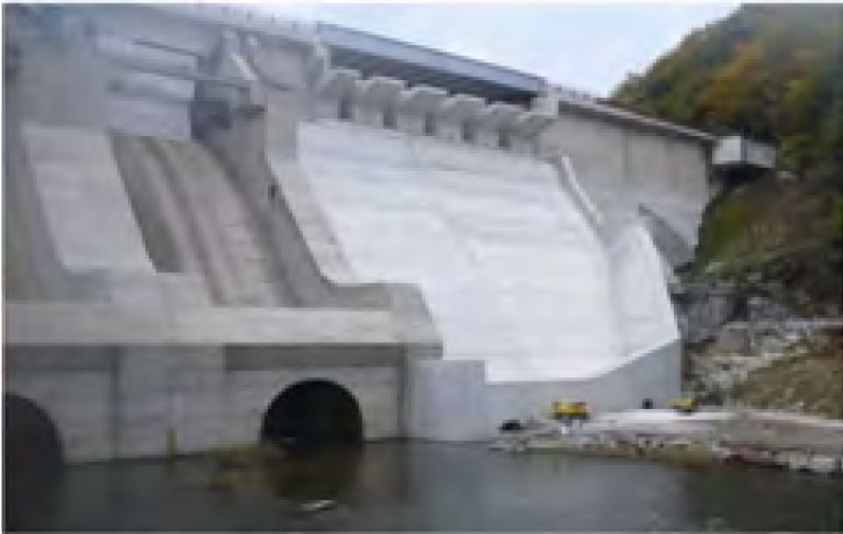
Figur 47: La Raviege dam, Frankrike. Avledningskapasitet utvidet ved etablering av PKW til venstre (sett i medstrøms retning) for hovedflomløpet. Bildet og informasjon om prosjektet er hentet fra Khanh et al. (2025)
