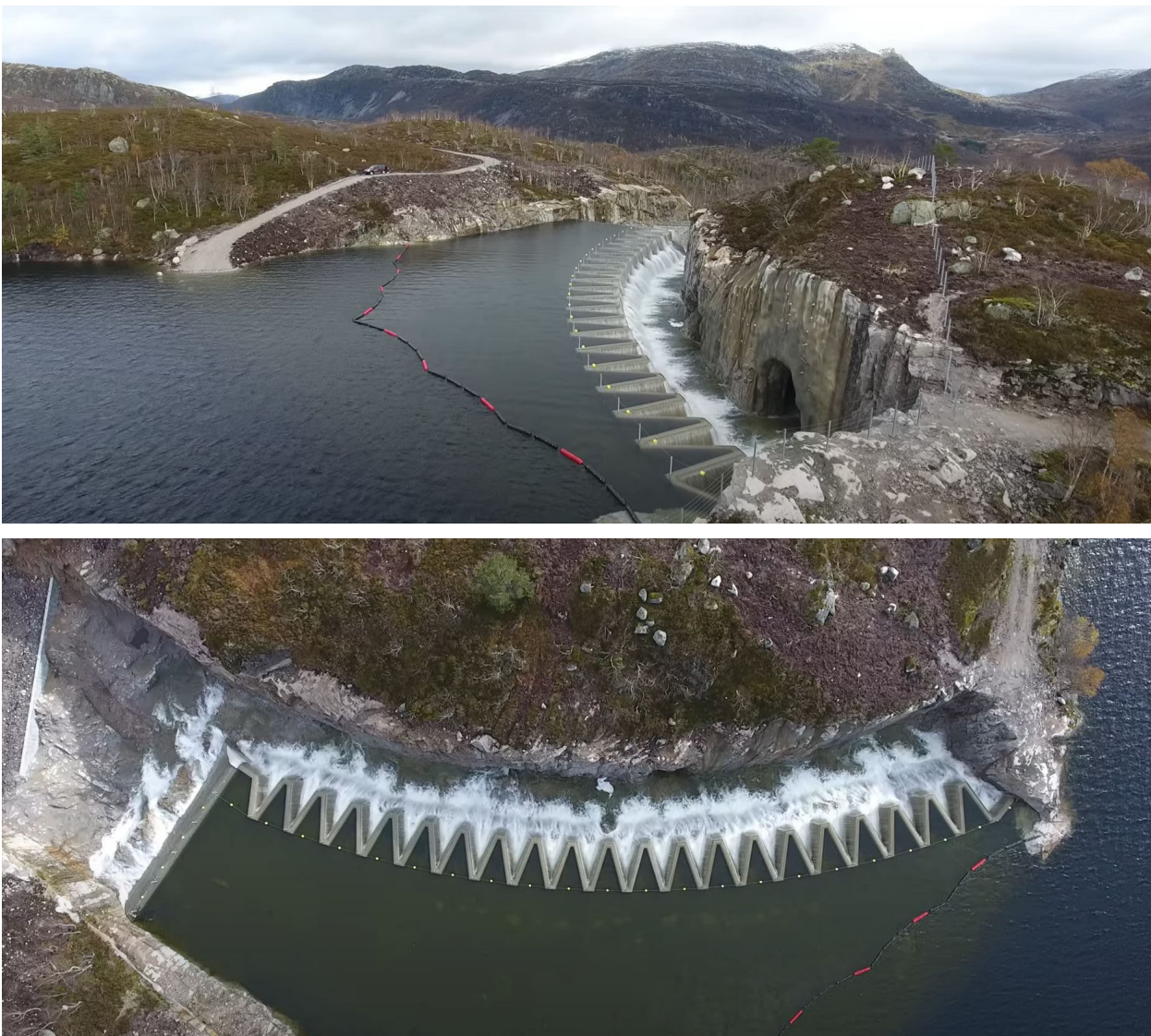
Figur 7: Bilder fra flom ved labyrintoverløpet ved Deg oktober 2017. Bilder hentet fra Sira Kvinas video ( https://www.youtube.com/watch?v=79VuGOFz7GI&t=1s )
