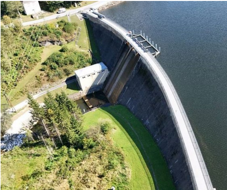
Figur B 7 Pack dammen i Styria a) Oversikt. b) Flomlukene (3 luker). (Bilder fra Burkhard, 2025 (epost)).
