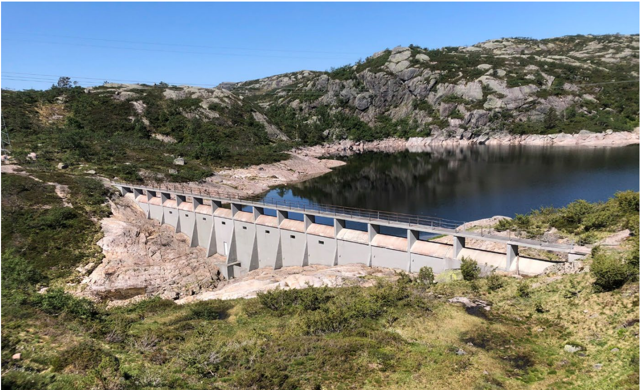
Figur A 5: Flomløpet over Sekundærdam 1
