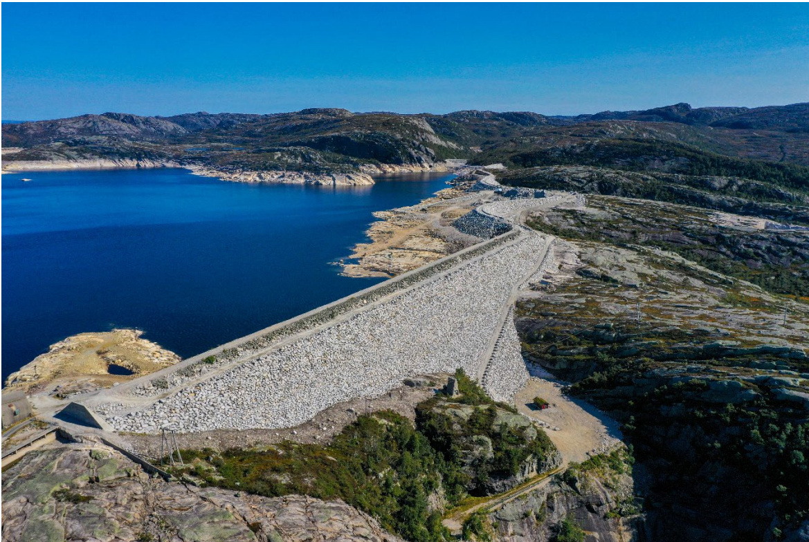
Figur A 2: Nesjen Hoveddam i forgrunnen og sekundærdam 2, 3 og 4 bortover mot bakkant av bildet (foto Sira-Kvina kraftselskap).
