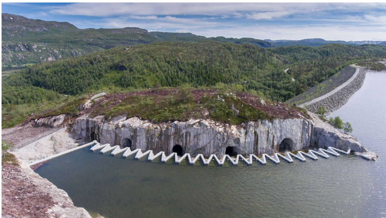
Figur 4: Labyrintoverløpet ved Dam Deg (foto fra Sira-Kvina kraftselskap), hvor reserveflomløpet er terskelen som ligger helt til venstre i bildet med mulighet for å lede vann ut av samlekanal dersom kapasitet til tunnelsystemet overstiges.
