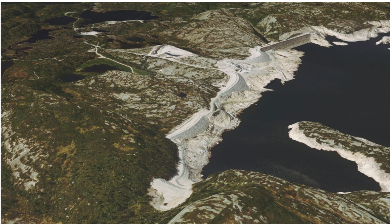
Figur A 3: Flyfoto i 3D av Nesjen dammene, sekundærdam 4 nærmest i bildet ( www.norgeibilder.no )
