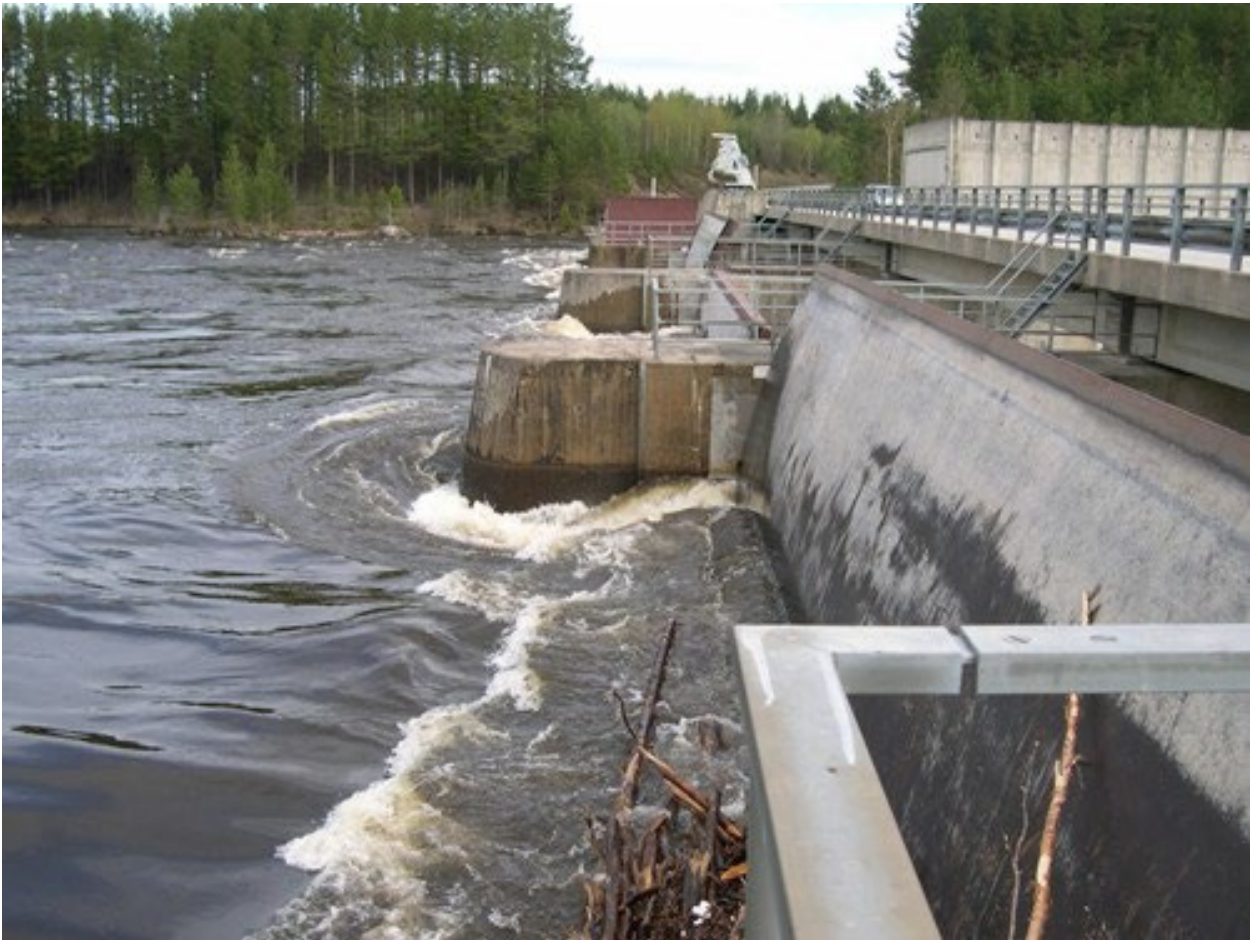
Figur A 9: Foto av oppstrømsside segmentlukedel av dam Braskereidfoss ( Jens Nicolai Thom, NVE, 13.05.2004 ).
