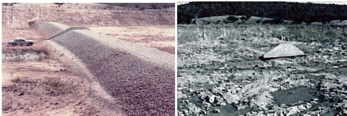
Figur 26 Sikringsdam ved Mnjoli dam a) før aktivering i 1985 (bilde fra Sheerman-Chase i (Hinks & Goff, 2018)) b) etter flomhendelsen og aktivering av sikringsdammene. Betongveggen mellom de to seksjonene står fortsatt. (Bilder fra (Engels, E.T.; Sheerman-Chase, 1985)).
