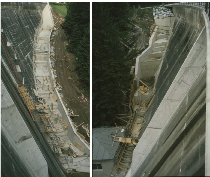
Figur B 8 Pack dammen i Styria. Bygging av betongkonstruksjonen for å ta imot vann som overtopper dammen. (Bilder fra Burkhard, 2025 (epost)).
