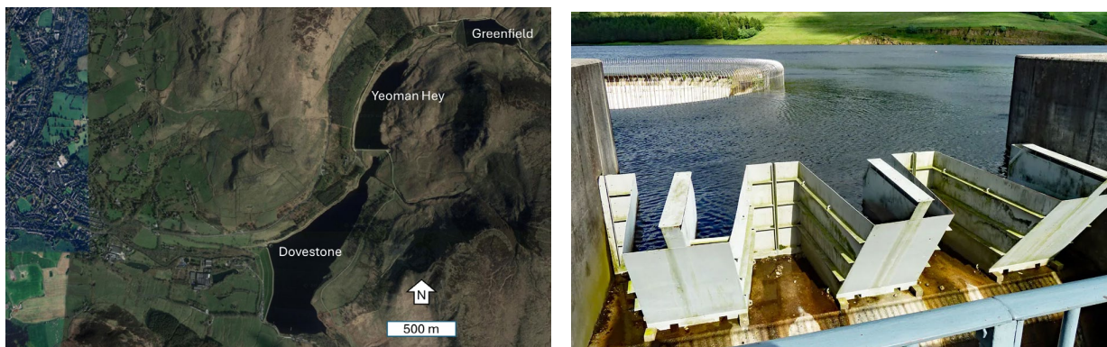
Figur B 18 Tre magasiner i UK med sikringsluker. a) Oversikt (Google Earth). b) Sikringsluker på Dovestone magasinet. (Figur fra https://www.doveheritage.com/1967-completion-of-dove-stone-reservoir/web-fuse-gates/ ).
