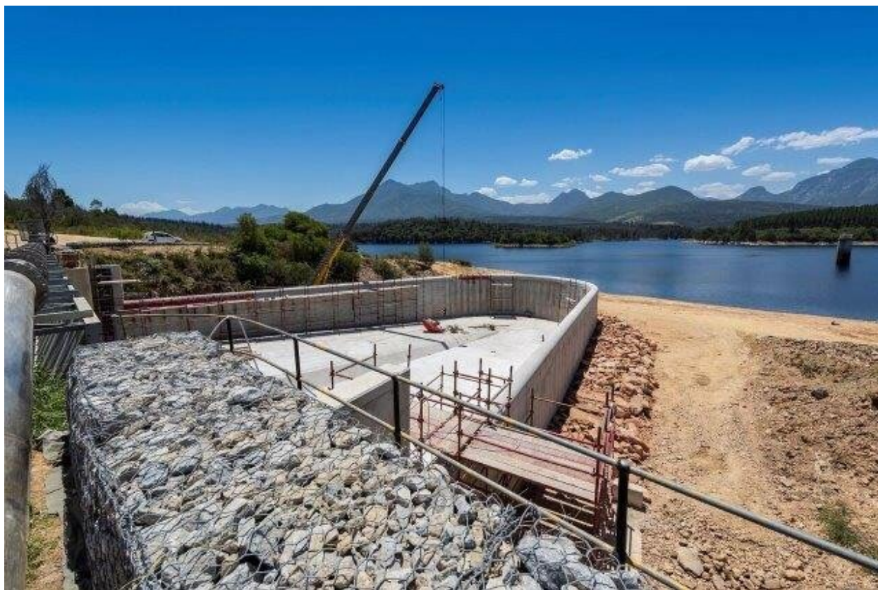
Figur 49: Bilde av et andenebb formet overløp (Duckbill). Bildet er hentet fra dam Garden Route i Sør Afrika ( https://bwa.co.za/the-borehole-water-journal/2020/6/11/ ) og er også nærmere beskrevet i Denys (2023))
