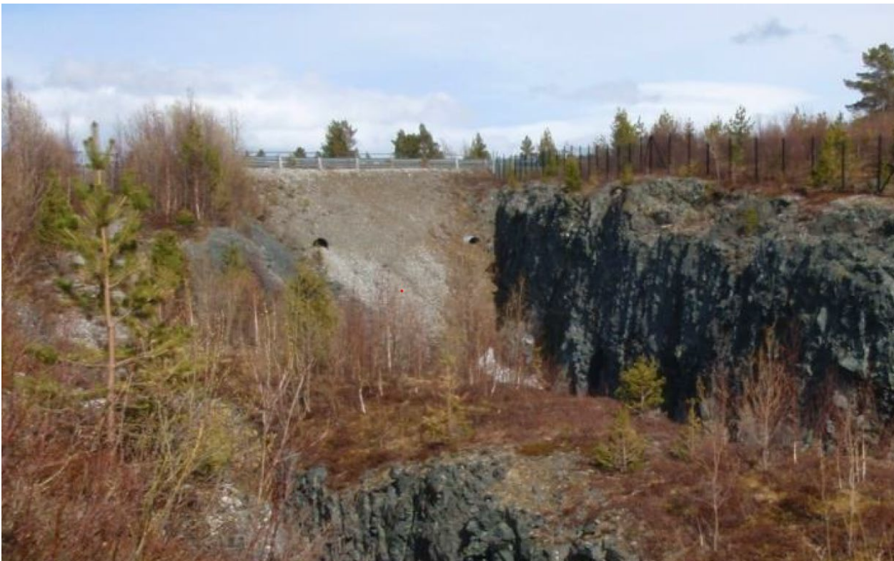
Figur 12: Sikringsdam ved Nerskogen (Sweco, 2016)
