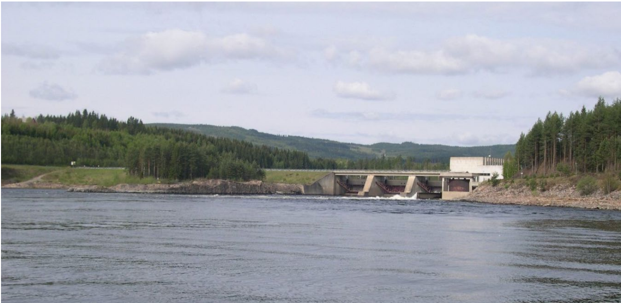
Figur A 8: Foto av dam Braskereidfoss sett fra nedstrøms side, fyllingsdam til venstre i bildet og flomluker til høyre i bildet ( Jens Nicolai Thom, NVE, 13.05.2004 ).
