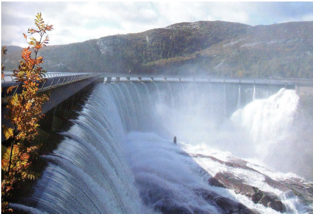
Figur 3: Flomløp ved Dam Kilen (foto fra Sira-Kvina kraftselskap)
