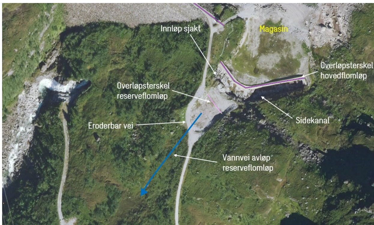
Figur 15: Flyfoto fra NVE Atlas av flomløpssystemet ved dam Øvre Kalvatn
