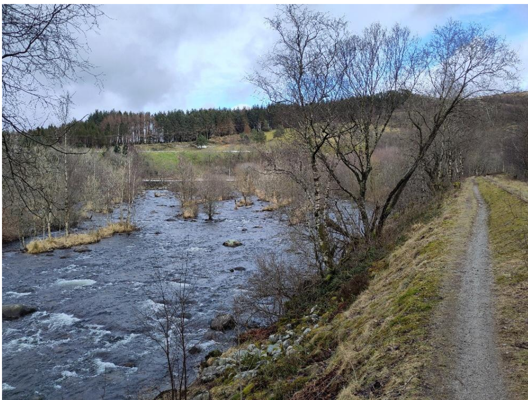
Figur 3.5: Situasjon utenfor tettstedet. Øyer med vegetasjon i elveprofilen og gjengrodde deler av profilen.
