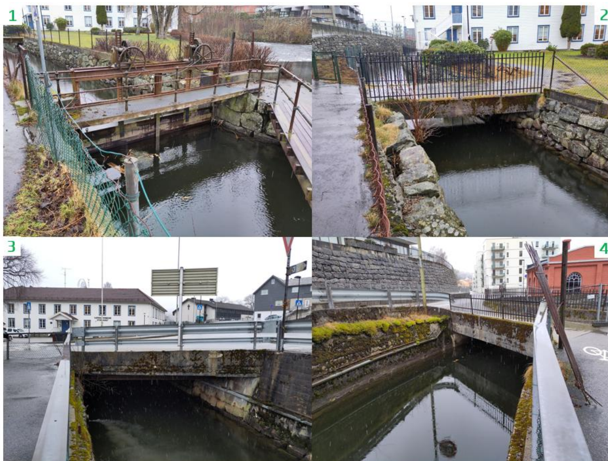
Figur 4.9: Bruer og konstruksjoner ved Ålgård kraftverkskanal. Bilder fra befaringen.
