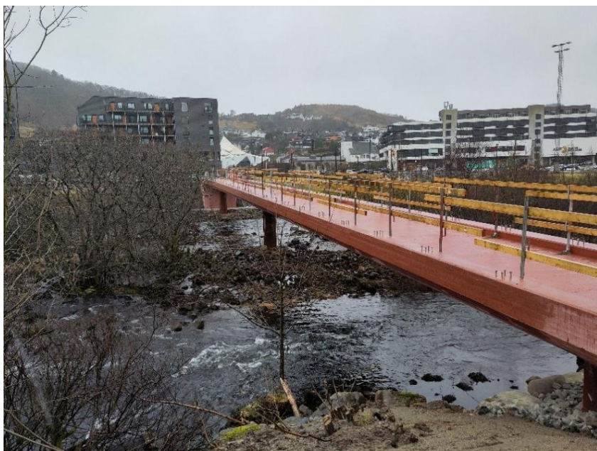
Figur 4.15: Gangbru under bygging ved Torgveien 20 i Ålgård. Bilde fra befaring.
