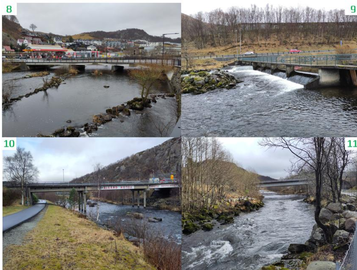
Figur 4.11: Bruer og dam i Figgjo ved Ålgård ned til Figved. Bilder fra befaringen.
