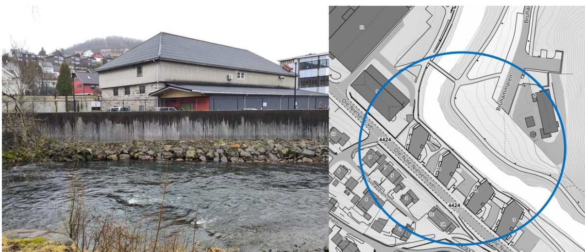
Figur 4.18: Bilde og beliggenhet av flomsikringstiltak ved Ole Nielsens vei 3-11 i Ålgård (Bilde fra befarings; bakgrunnskart: Norgeskart, Kartverket)
