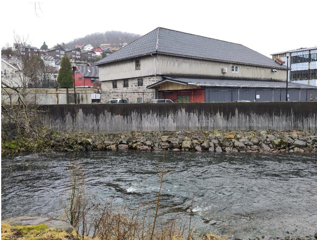
Figur 3.4: Typisk elveprofil på strekningen av Figgjo nedstrøms kraftverket gjennom Ålgård. Forbygd elvebredd, sikret ved betongmur på toppen av sidesikringen.
