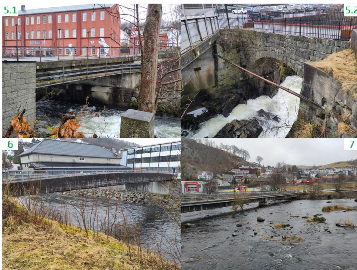
Figur 4.10: Bruer over Figgjo ved Ålgård. Bilder fra befaringen.
