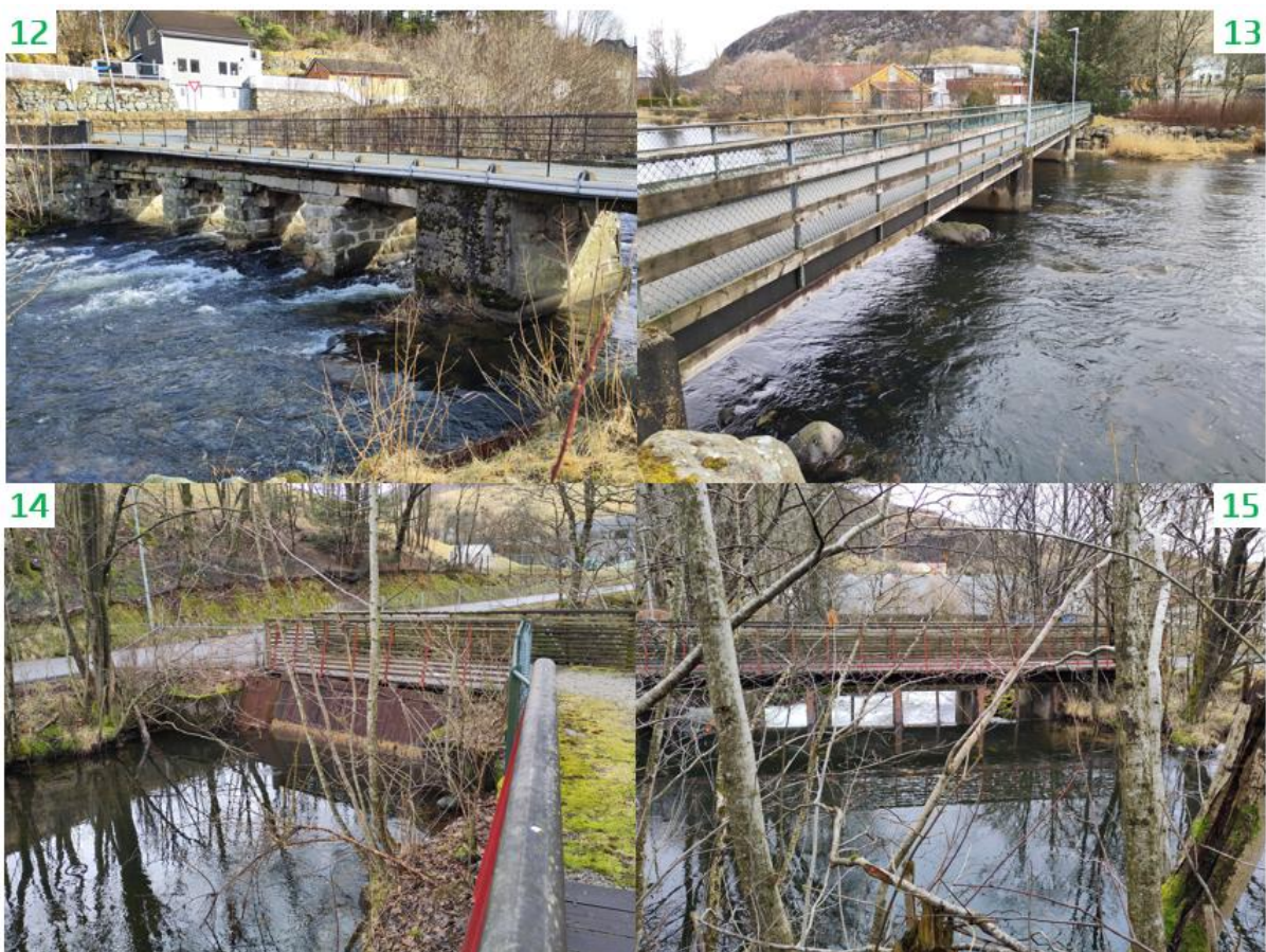
Figur 4.12: Bruer og dam i Figgjo og ved Figgjo skole. Bilder fra befaringen.
