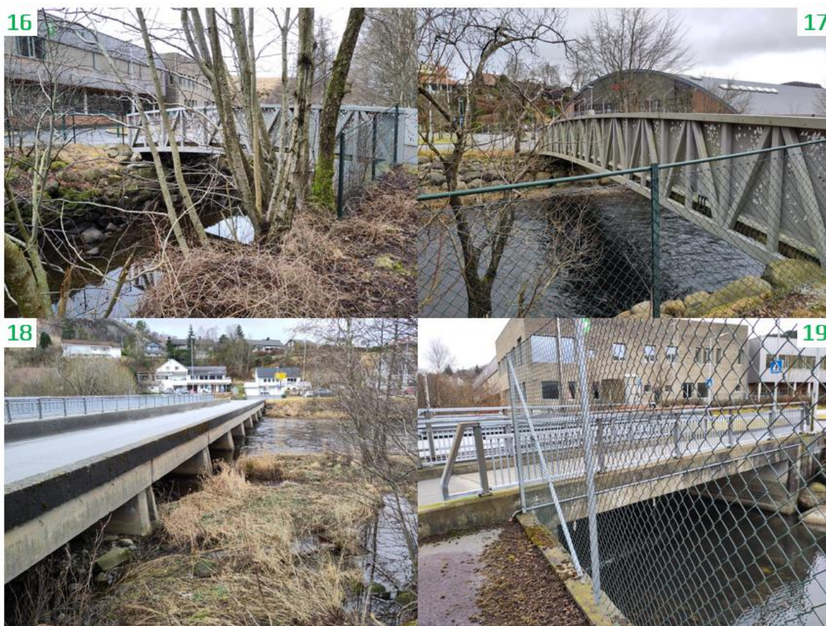
Figur 4.13: Bruer ved Figgjo skole. Bilder fra befaringen.
