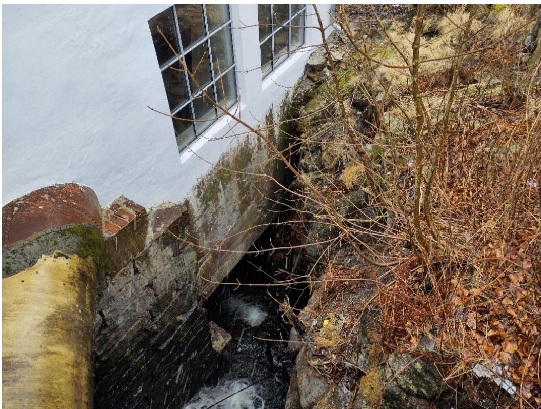
Figur 3.3: Situasjon ved vannkraftverket i Ålgård under befaringen. Vannføringen gjennom kraftverket og tilbake til Figgjo er ukjent.
