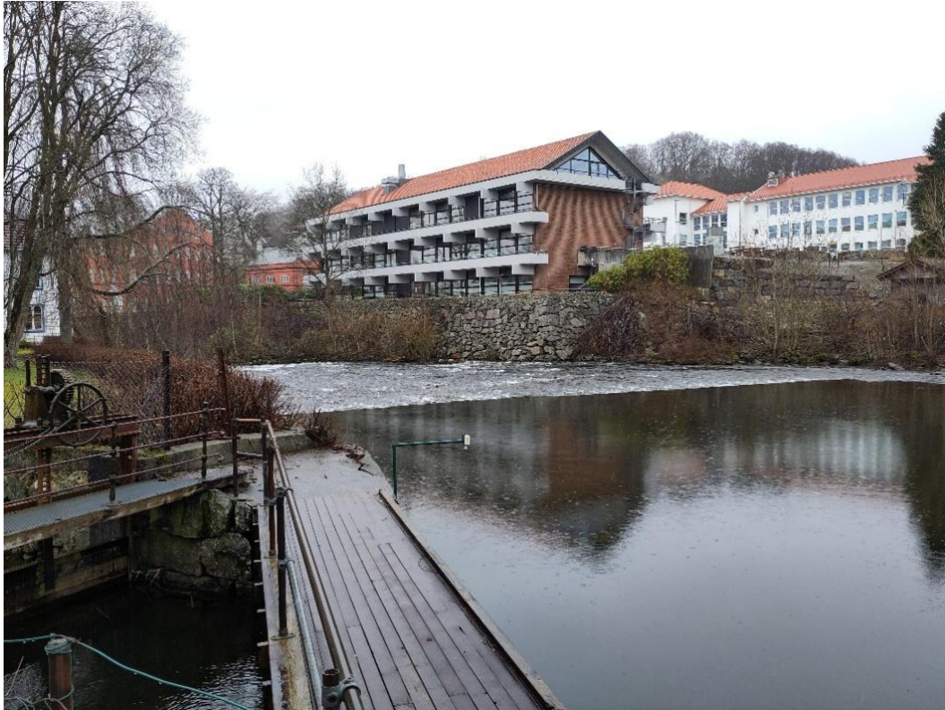
Figur 3.2: Situasjon ved starten av det modellerte elveløpet under befaringen. Foran til venstre i bildet luken ved øvre ende av kraftverkskanalen. Foran til høyre vannspeilet av Edlandsvatnet.
