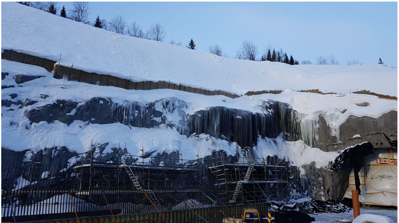
Figur 1: Eksempel på anleggsområde tett på løsneområde, fra bygge av løsmassetunnel på E16 Øye 2017. Foto: Wyssen Norge AS
