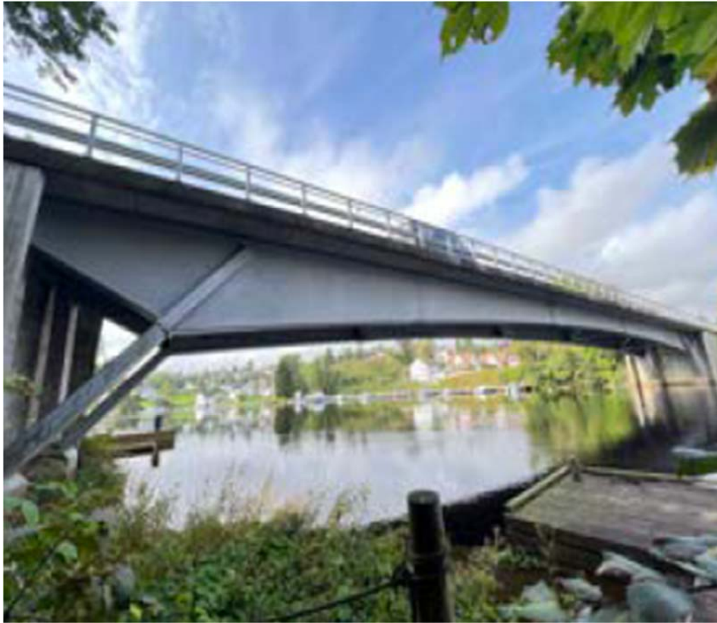
Figur 5-7. Hammer bru sett motstrøms. Kilde: Statens vegvesen.
