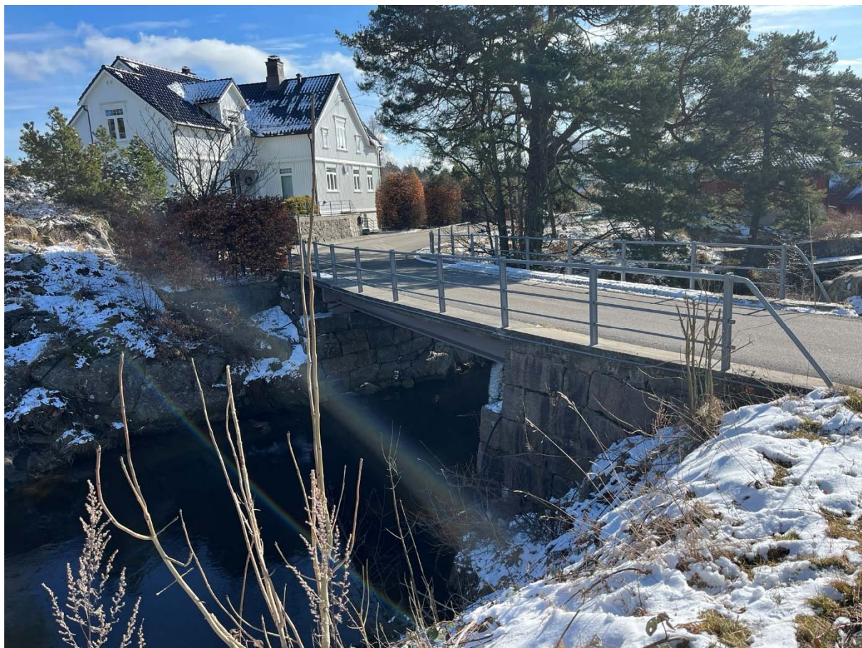
Figur 5-17. Store Bjørholmen bru sett fra oppstrøms side.
