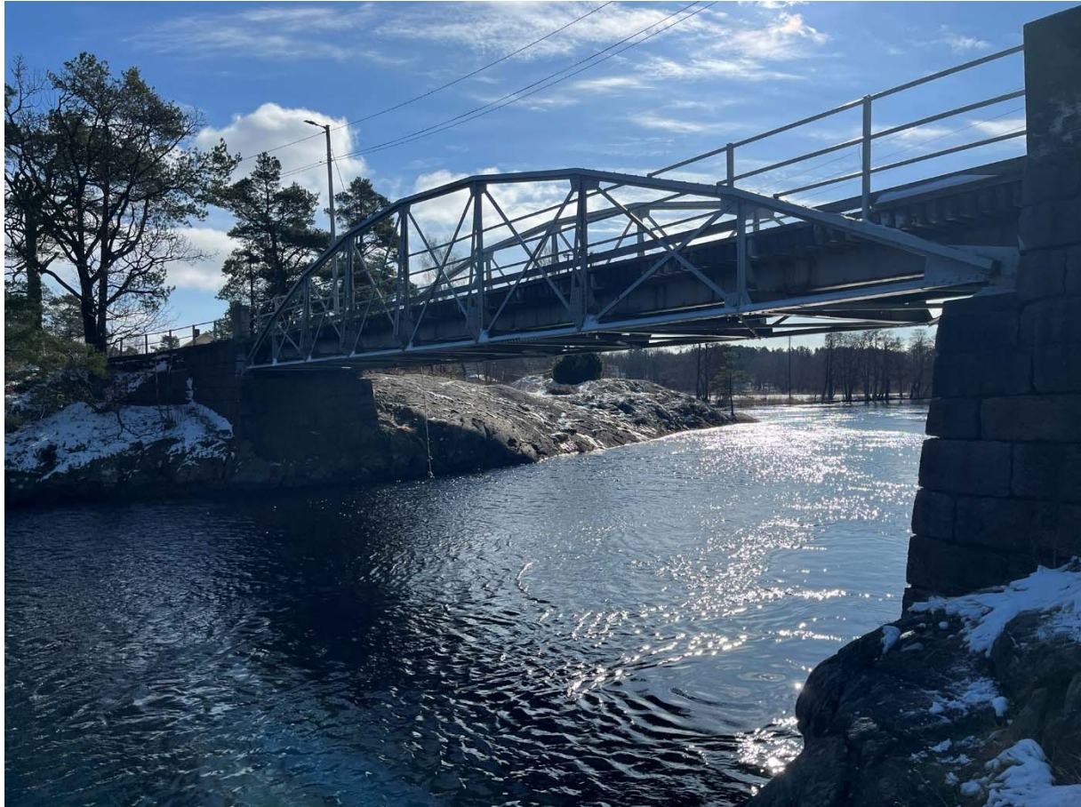
Figur 5-19. Lille Bjørholmen bru sett fra oppstrøms side.
