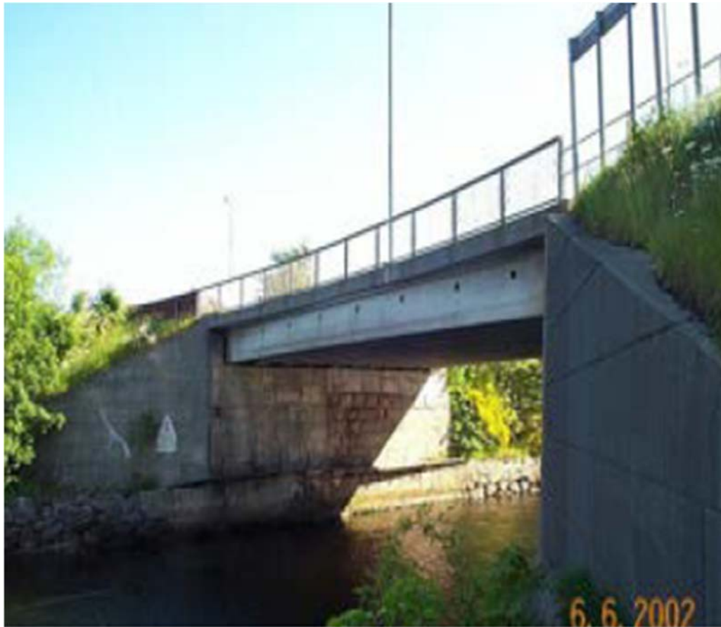
Figur 5-9. Strømmen bru sett motstrøms. Kilde: Statens vegvesen.
