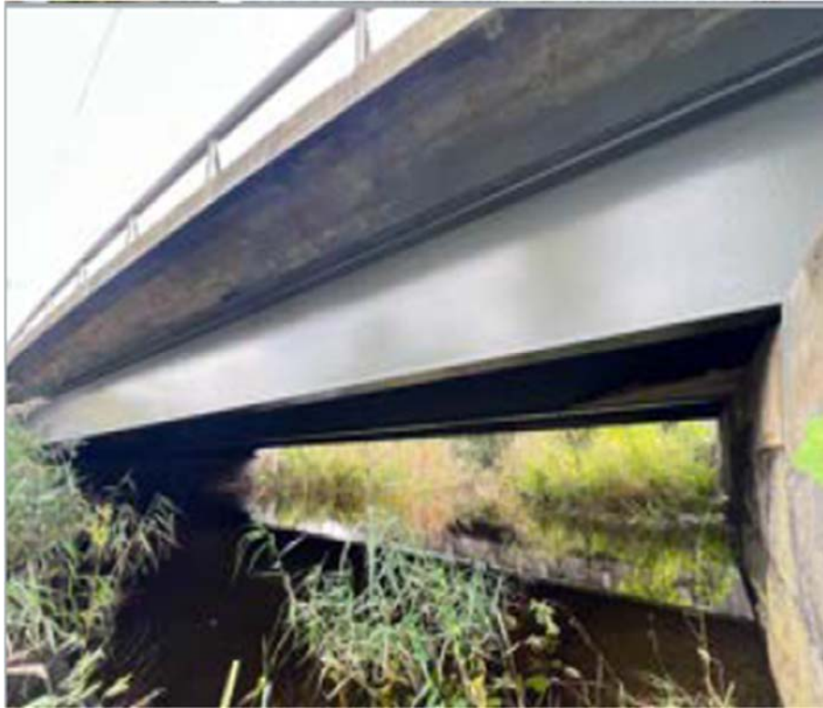
Figur 5-15. Engholmen bru sett medstrøms. Kilde: Statens vegvesen
