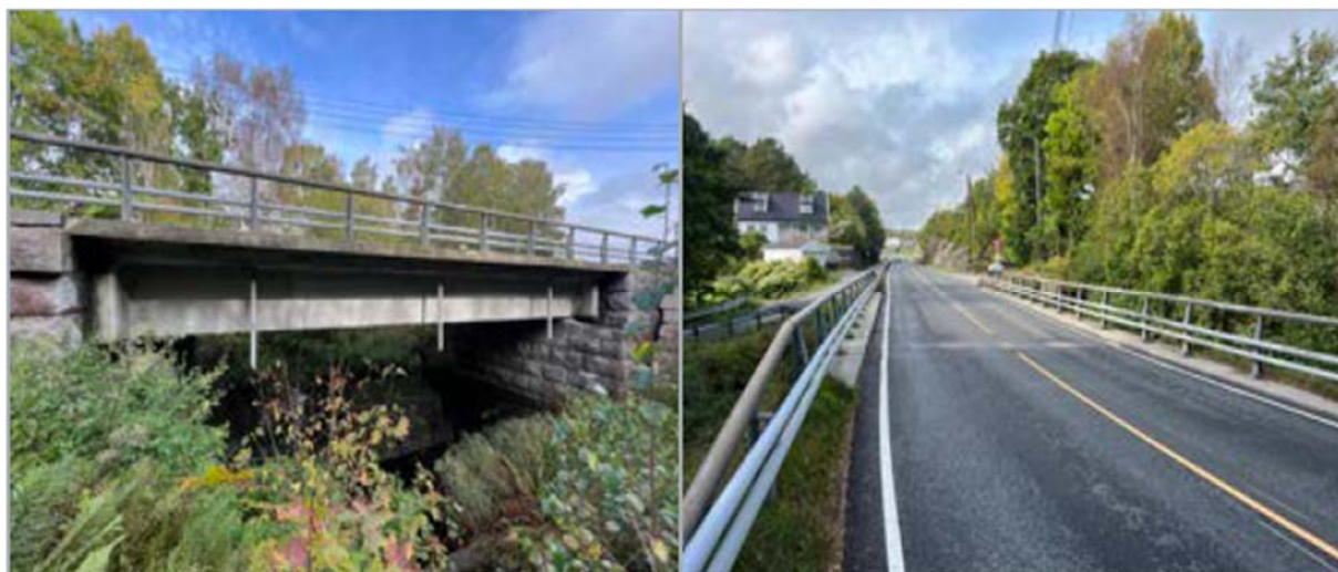
Figur 5-11. Mose bru sett motstrøms. Kilde: Statens vegvesen.
