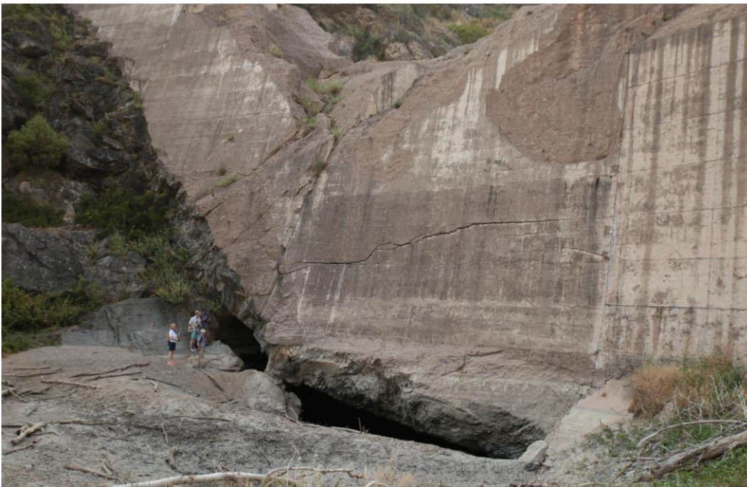
Figur 4-1 Dam Malpasset i dag. Dammen gikk til brudd 2. desember 1959. Foto: NVE.
