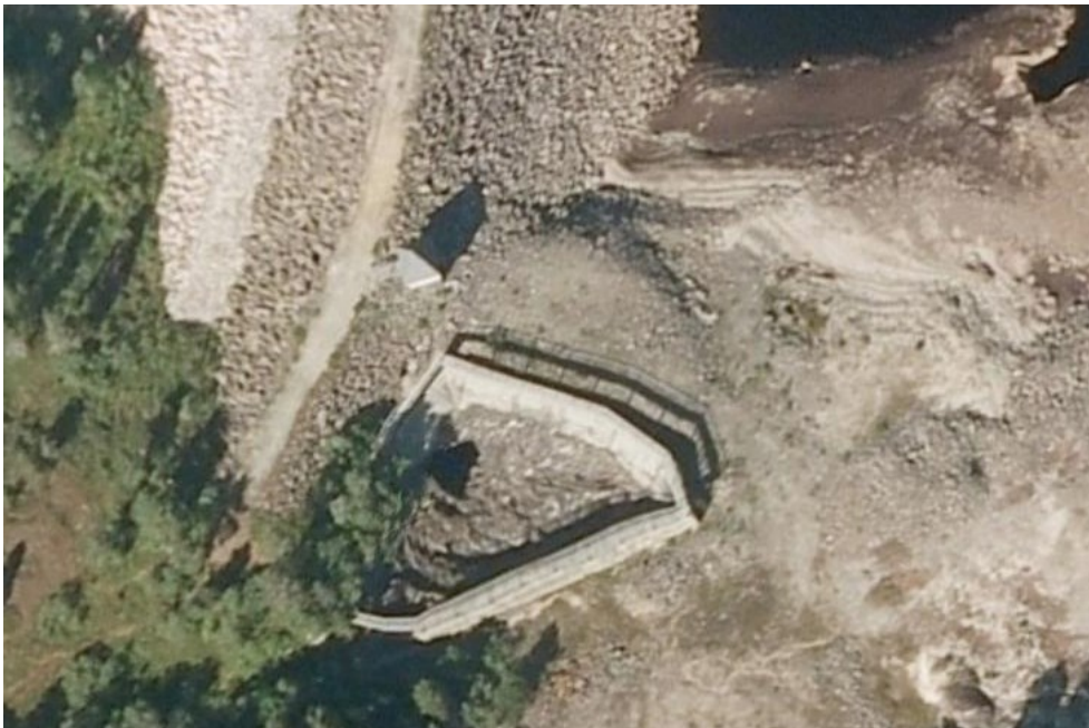
Figur 4-13. Flomløpet ved dam Vasslivatnet før ombygging
