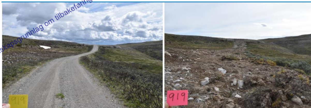
Figur 3-2 Tilbakeføring av vei gjennom Svånådalen i Hjerkinnskytefelt, før- og etterbilde.
