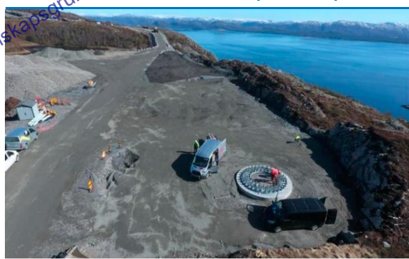
Figur 2-3. Kranoppstillingsplass med fjellforankret turbinfundament, Hundhammerfjellet vindpark
