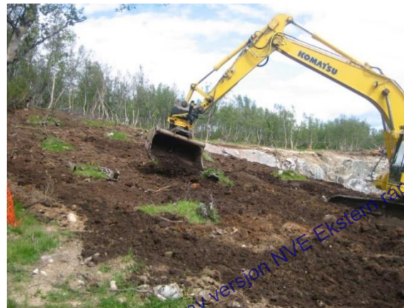
Figur 2-9 Utlekking av transplanterte vegetasjonsflak ved istandsetting av steinbrudd i Bitdalen
