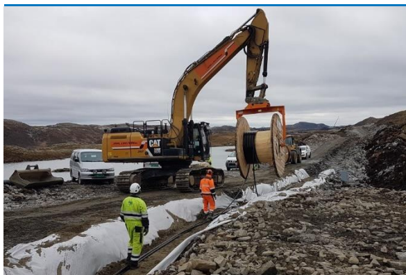
Figur 2-5. Legging av høyspentkabel (jordkabel) i Roan vindkraftverk
