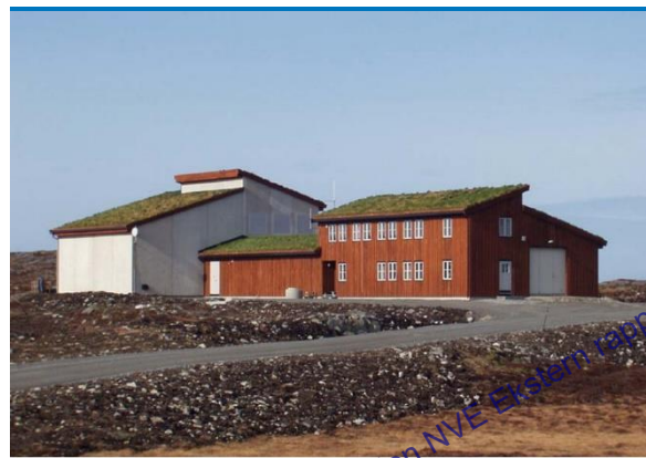
Figur 2-4. Transformatorstasjon og servicebygg ved Smøla vindkraftverk
