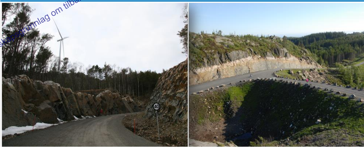
Figur 2-1. Venstre bilde: Veier og skjæringer fra Lista vindkraftverk. Høyre bilde: Veier, skjæringer og fyllinger fra Midtfjellet vindkraftverk
