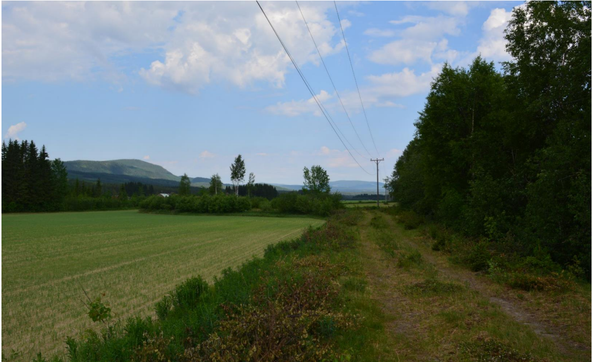
Figur 7: Oversiktsbilde over Mellem-Rustad flomverk. Tatt i nedstrøms ende med utsyn nordover (Bilde: Multiconsult).
