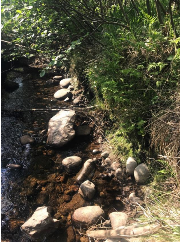
Figur 9: Undergraving mot Nord-Rustadbekken, pel nr. 40 -80. (Bilde: Multiconsult).
