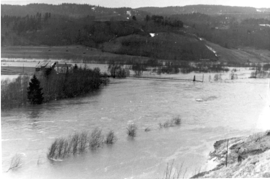
Figur 8. Holmsberget bro ved samløpet mellom Inna og Verdalselva under flommen i 1947. Broen reiste til slutt av gårde. (Kilde: Verdalsbruket AS ved Jon Lykke)
