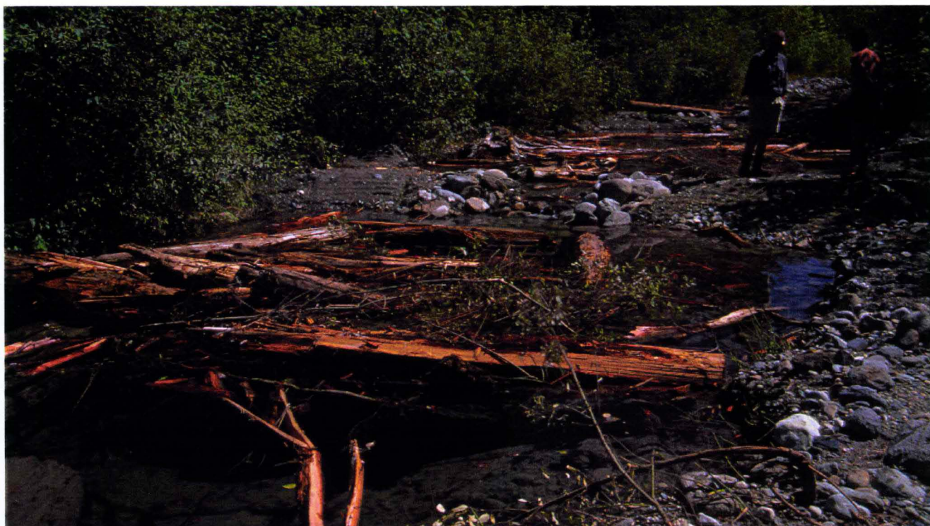
Sidekanal til Chilliwack river. Kanalen var ferdig en uke før bildet ble tatt. Trevirket i hølene er lagt på plass. Det er klart for å sette stiklinger i grusområdene rundt kanalen.
