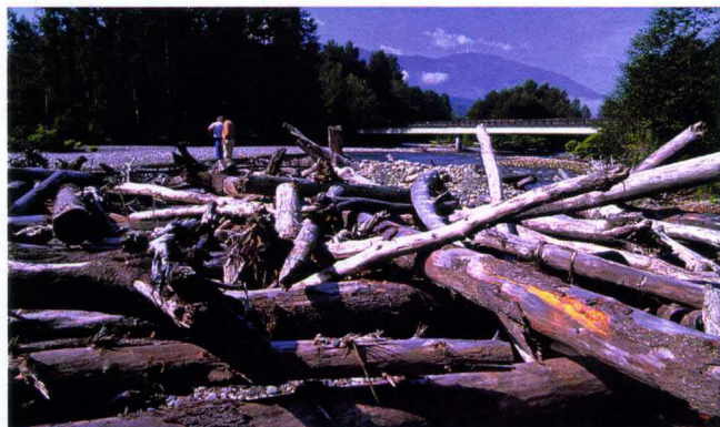
Kombinasjon med tømmer i front og kjerne sammen med mye stein og grus som dekker og avslutter konstruksjonen i bakkant.
