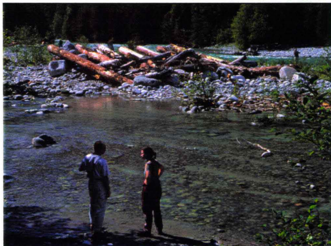
Drifttømmerfanger i Ashlu river. I dette prosjektet hadde canadierne ikke akkurat lagt flid i å få til et utseende som passet godt inn i naturen. Konstruksjonen var ny og hadde ikke fått vist hva den dugde til i flom.
