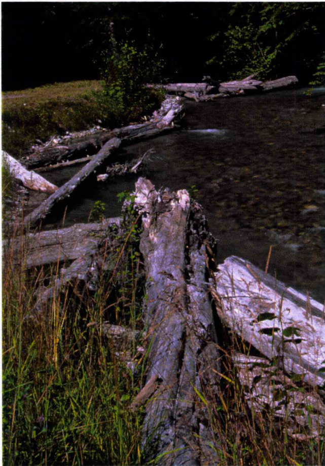
Tømmer brukt som erosjonsvern og skjul for fisk. Ashlu river.
