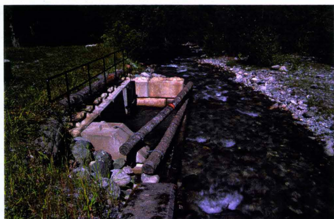
Inntak til sidekanal i Chilliwack river. Inntaket var plassert i en svak innersving og hadde problemer med at det fanget mye sand og silt. Anlegget var utstyrt med reguleringsluke slik at det kan slippes kontrollerte flommer gjennom sidekanalen
