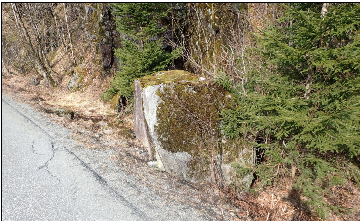
Figur 10 Blokk som vart remobilisert vinteren 2006/2007.
