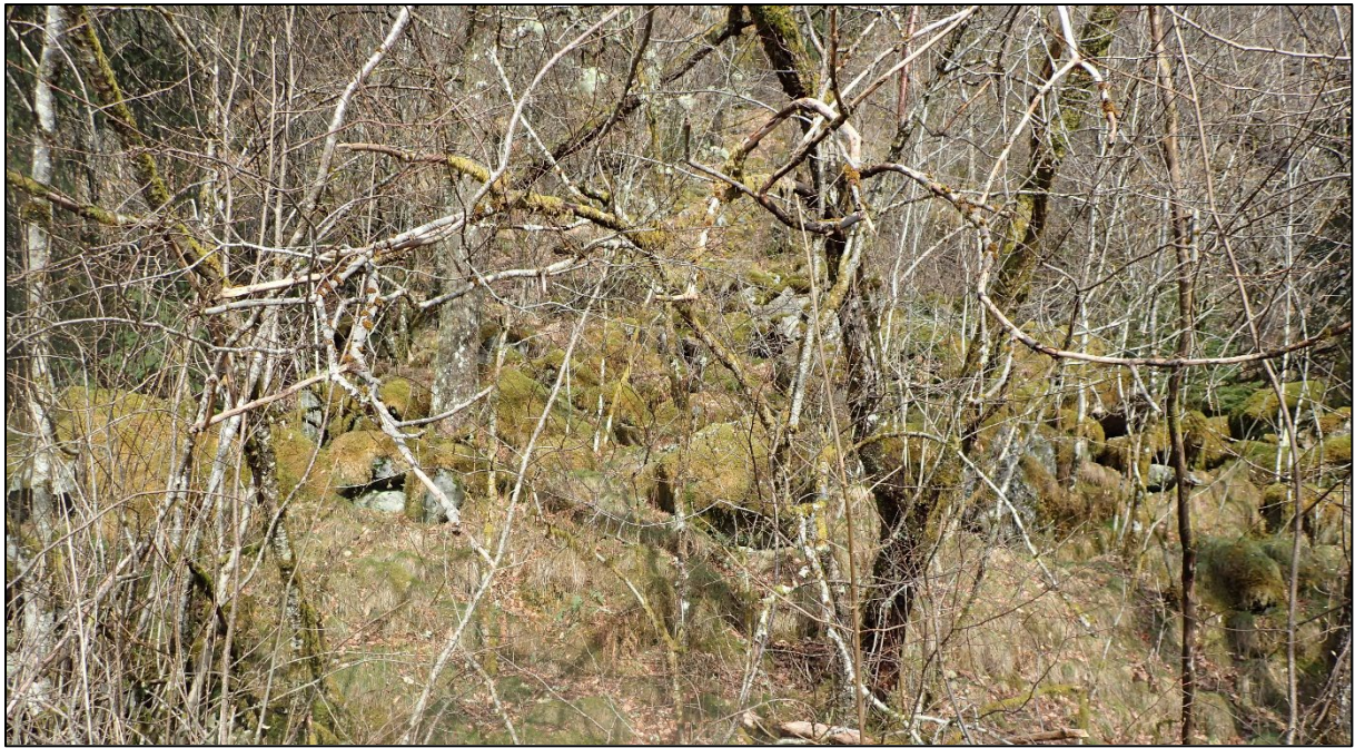
Figur 5 Steinsprangur over Modalsvegen 1546.
