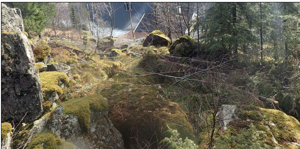
Figur 8 Steinsprangur over Modalsvegen 1664.
