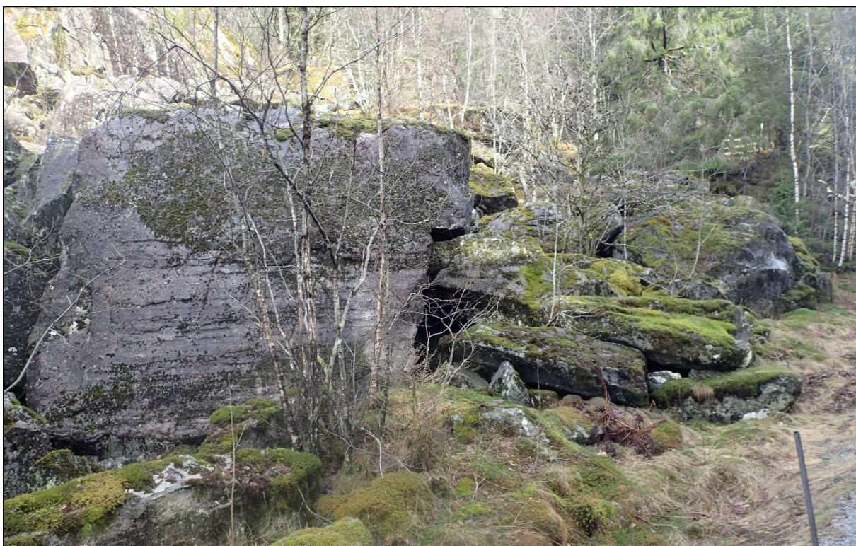
Figur 9 Område der det gjekk steinskred i 1975.
