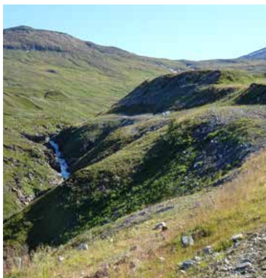
Figur 3: Revegetert og tilbakeført som kjøresterkt terreng tre år etter bygging. Skjæringer og fyllinger bakover i bildet er dempet mens bærrelaget under vekstmassene er intakt.
