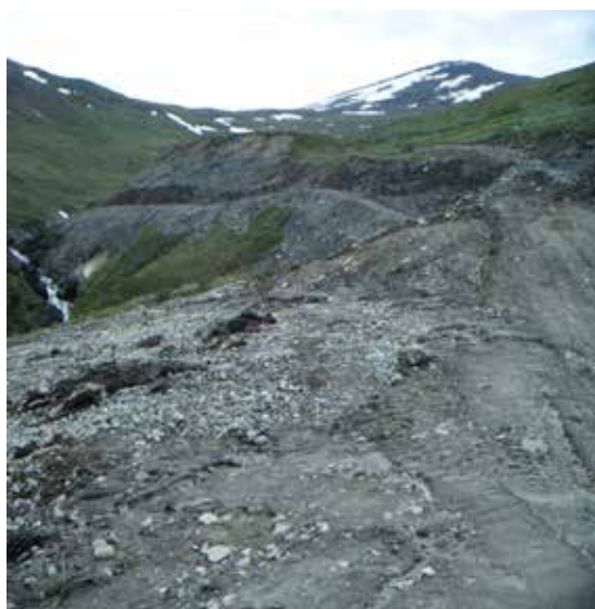
Figur 2: Bygging av Dittielva kraftverk. Midlertidig anleggsvei og rørgate opp til inntaket.
