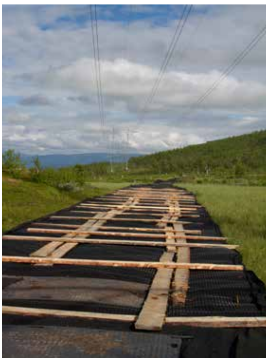
Figur 7: Ved å legge ut matter og planker i kjøretraséen kan terrengskader minimeres.
