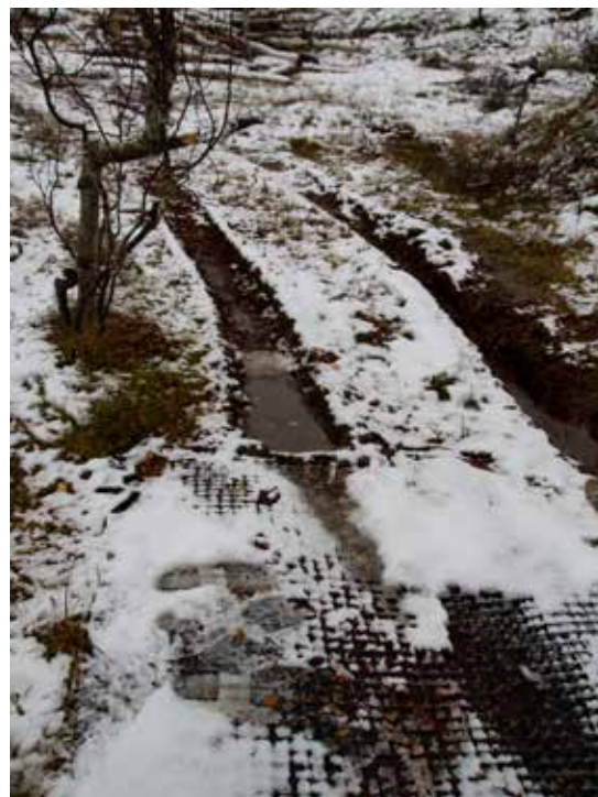
Figur 8: Geonett kan legges ut i våte områder for å minimere kjøreskader.
