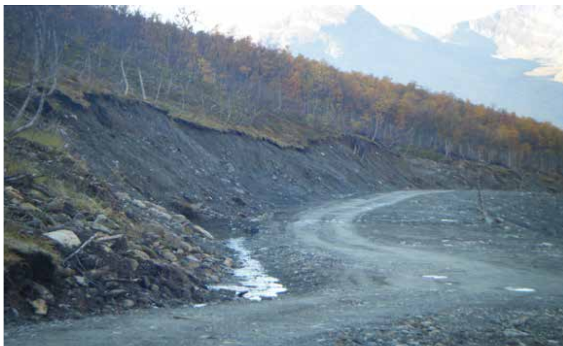
Figur 1: Midlertidige veier må utformes slik at det er mulig å legge dem igjen. Veibredden og veitraséen bør legges slik at man unngår å få store og ustabile skjæringer.
