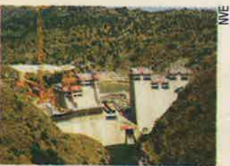
Dam under bygging i Sør-Spania.
