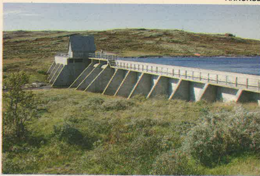
Dam Sverjesjøen i Kvikne kommune. En av de nyeste dammene i TrønderEnergi.
