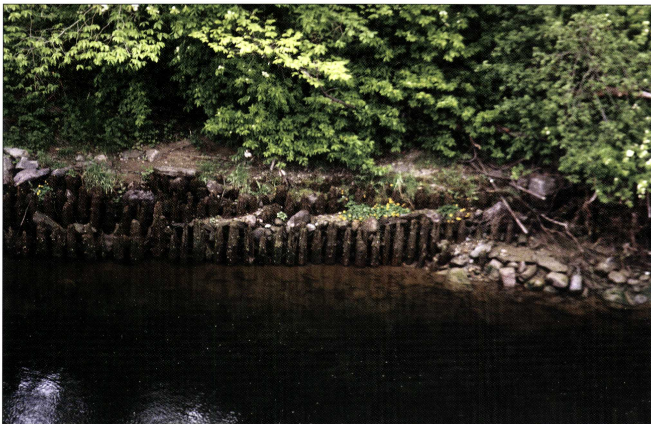
Pælerekke i Nidelva. Rester av gammel forbygningskonstruksjon fra 1730. Foto: E. Sæterbø, NVE.
