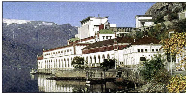
Tyssedal kraftstasjon bygd 1906-1918. Foto: Arvid Aga/Tyssedalsprosjektet.
