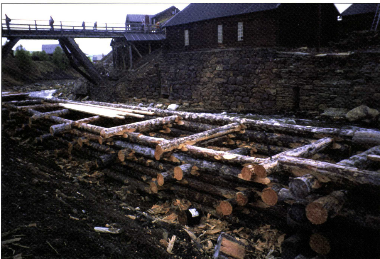
Samarbeidsprosjekt Riksantikvaren og NVE - antikvarisk restaurering av elveforbygninger ved Hitterelva, Roros 1999. Foto: NVE.
