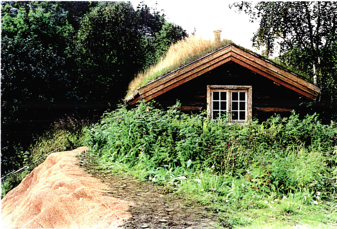
Toppen er ferdig og arbeidet nærmer seg slutten.
