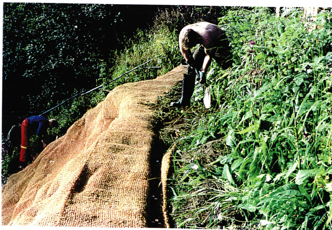
Toppgrøfta legges igjen.
