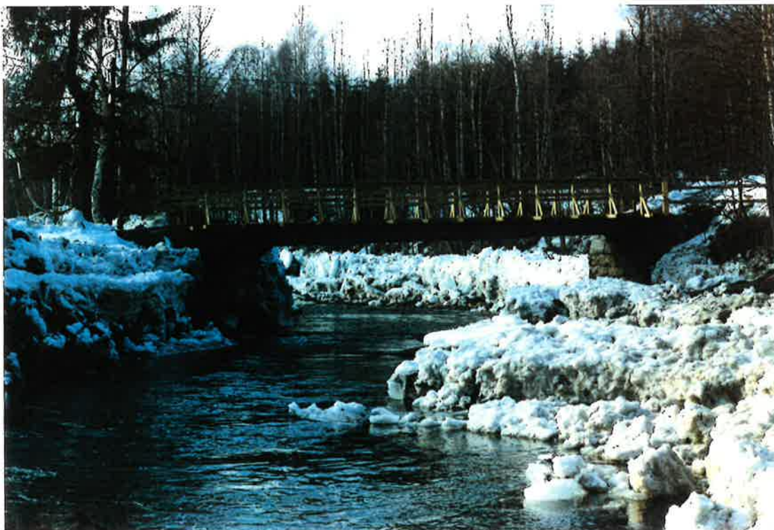
Figur 5. Heggelielva nedenfor brua til Nedre Gran etter isgangen i april 1991. Foto: Arve Sandbråten.
