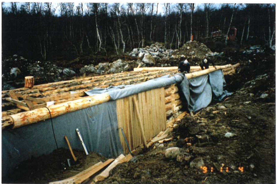
SOM TETNING OPPSTRØMS BLE DET LAGT PLANKEVEGG, FIBERDUK OG MORENE. MORENEN ER BESKYTTET MED STEINMASSER. YTTERST TØMMERSTOKKER (ISAVVISERE), SE FORØVRIG OMSLAGSBILDE. ALT TØMMER I DAMMEN BESTÅR AV UBEHANDLET, HÅNDBARKET FJELLFURU.
