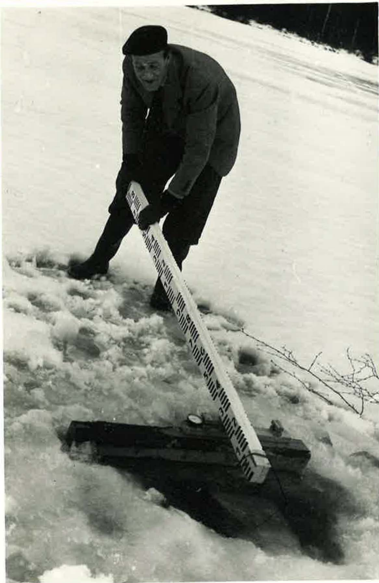
Måling av isens bruddfasthet 24/11 1952
