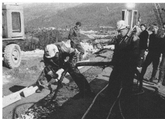
Dam Gråsjø, fylling av asfaltbetongkjerne.
