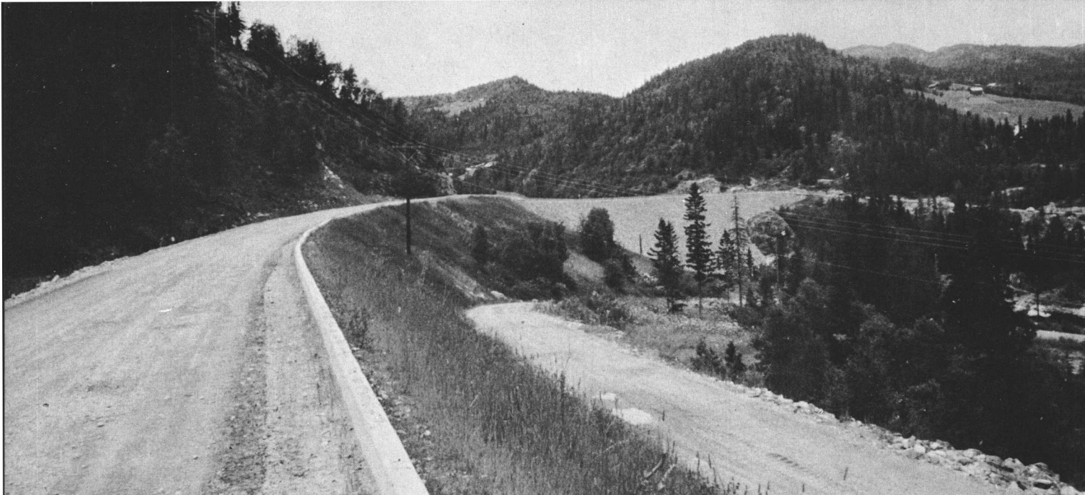
Dam Tunnhoved med riksvæg.
