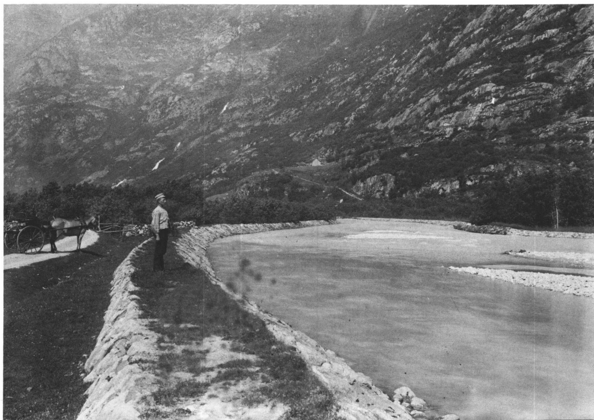
Forbygning mot Oldenelva ca. 1896.
